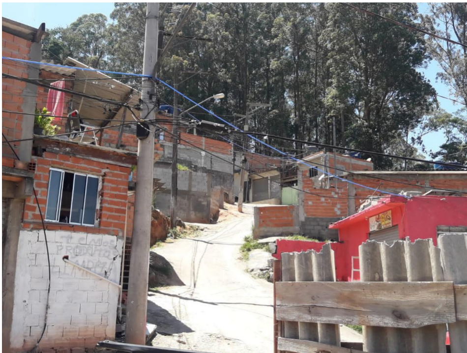
FC.PJ-05-02.2: Vista da parte inferior do setor. Notar as construções em alvenaria.
