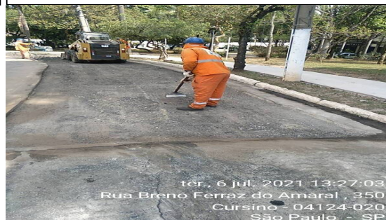
26 | Item de OS 4931311 (06/07/21 17:24 MXINTADM) - Excesso da distância aceitável entre o local da ordem de serviço e foto capturada.
