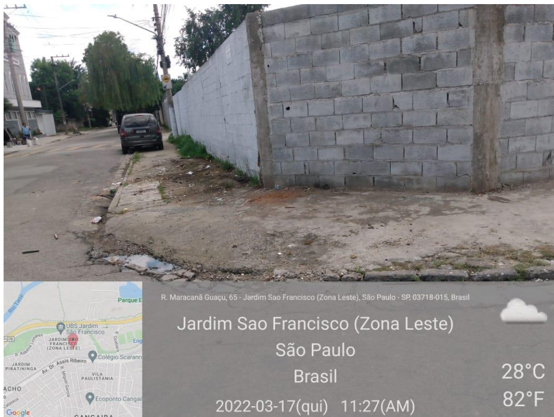
Figura 2 Rua Guira Acangatará - remoção de entulho
