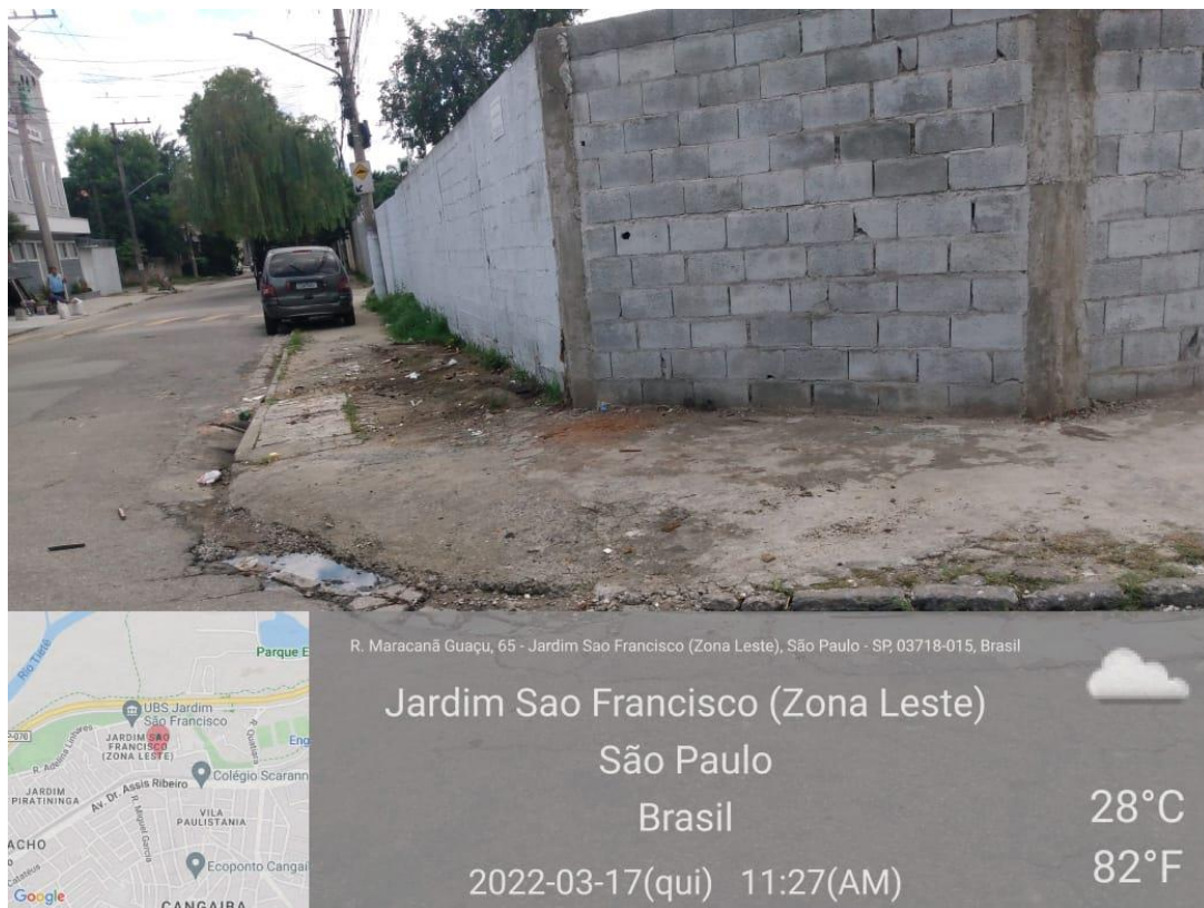
Figura 2 Rua Guira Acangatará - remoção de entulho
