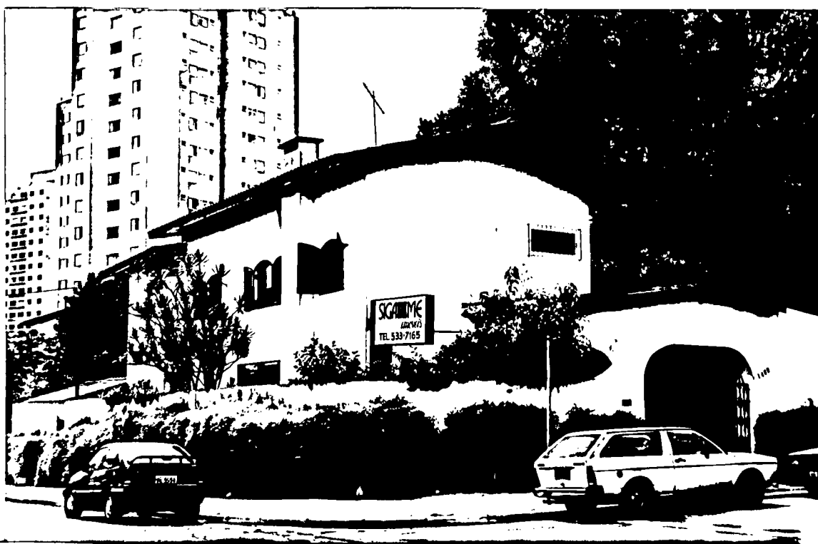
RUA DEMÓTINES ESQUINA COM RUA VICENTE LEPORACE
