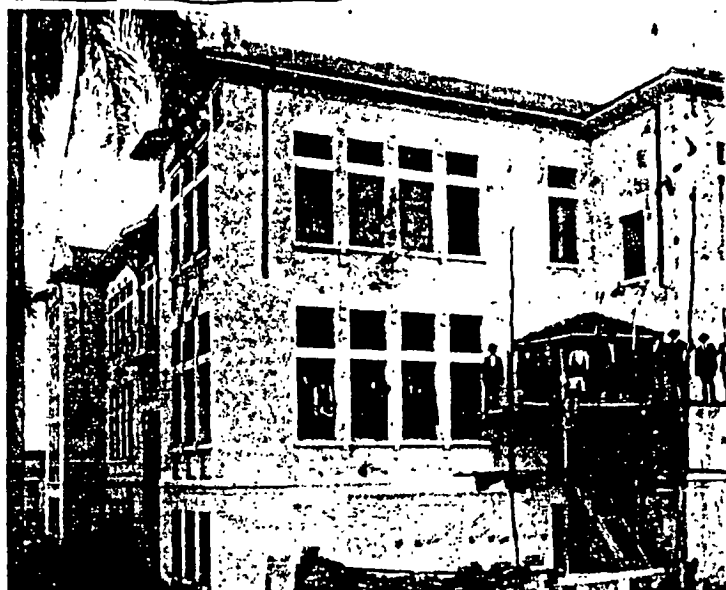
F.E.P.G. "Colégio Oswaldo Cruz" já em fase de acabamento Foto 1913. Inaugurado em 1914
