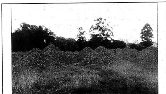
Foto nº 09 – Monturos de resíduos de inertes originários de edificação existente na área.
