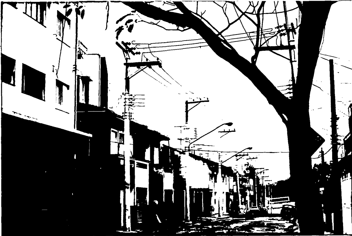
LADO PAR, SEM RECUO PARA REALIZAR O ALARGAMENTO DA RUA , SENDO NECESSÁRIO A DEMOLIÇÃO TOTAL DE 41 CASAS. CONFORME PODE SER VISTO, OS POSTES SÃO NOVOS E FORAM RECENTEMENTE REMANEJADOS PARA O LADO PAR.
