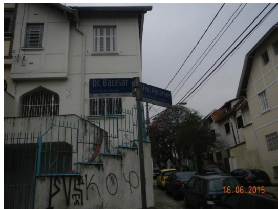
Conjunto residencial horizontal da Rua Francisco Aquarone
