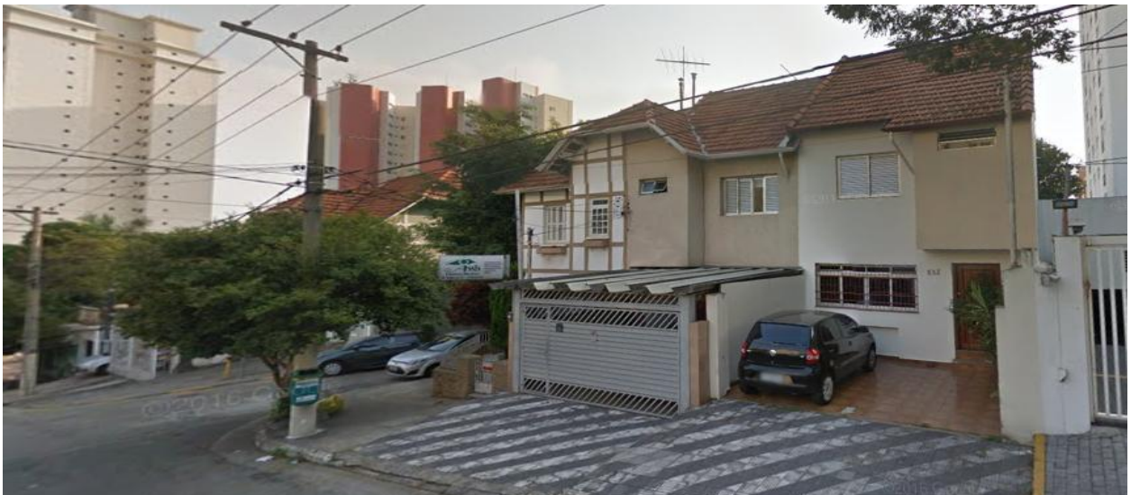
Conjunto residencial horizontal da Rua Francisco Aquarone
