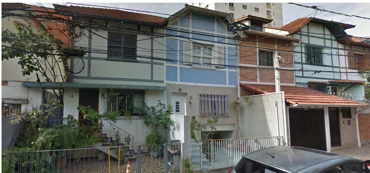
Conjunto residencial horizontal da Rua Francisco Aquarone
