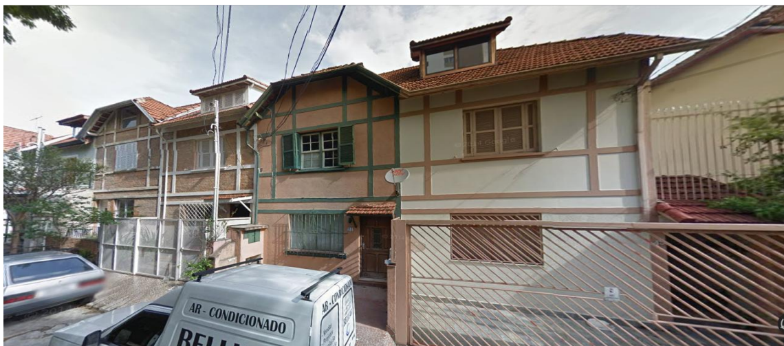
Conjunto residencial horizontal da Rua Francisco Aquarone
