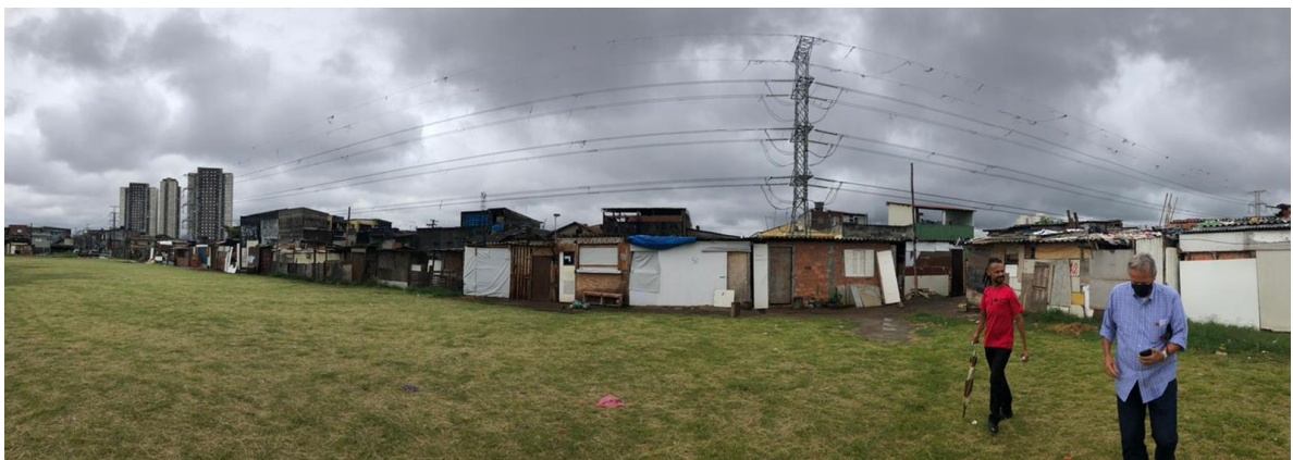
Imagem 16 – Parte da ocupação situada em faixa non aedificandi da linha de transmissão e do córrego
