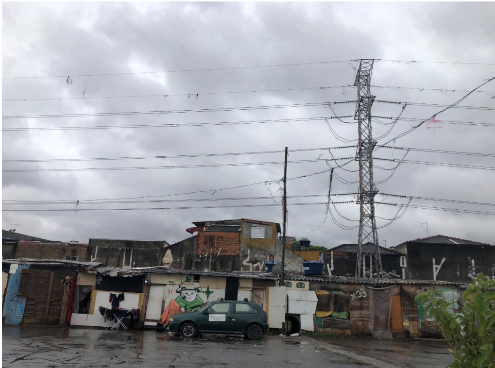
Imagem 6 – Estrutura das habitações e rede de transmissão de energia
