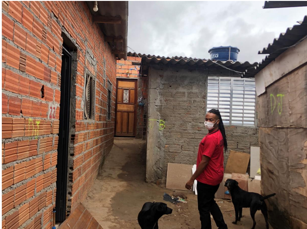
Imagem 8 – Estrutura das habitações - alvenaria
