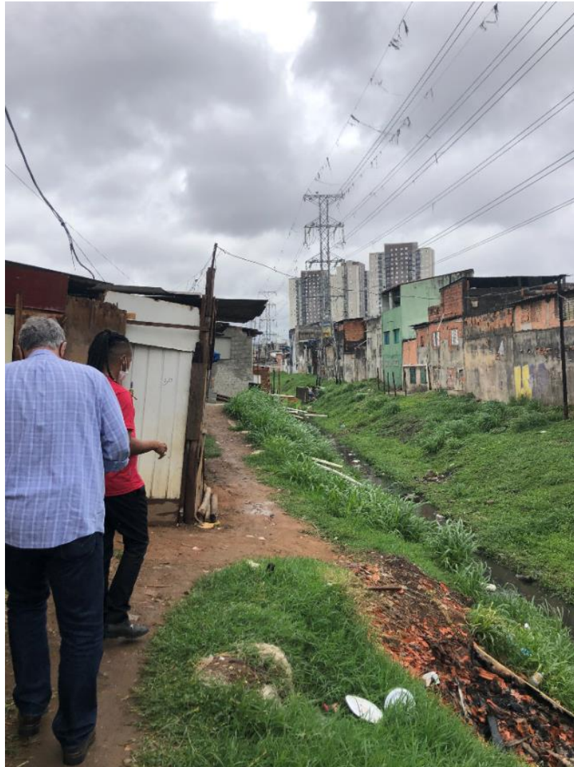
Imagem 17 – Parte da ocupação situada em faixa non aedificandi da linha de transmissão e do córrego
