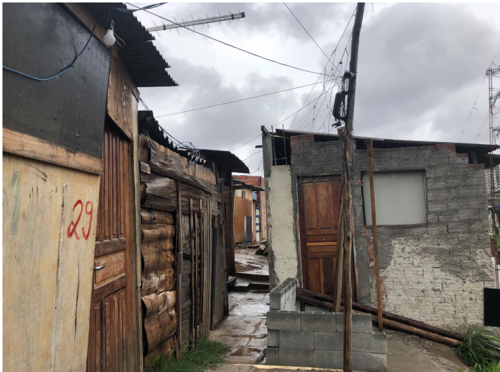
Imagem 7 – Estrutura das habitações – alvenaria e madeira
