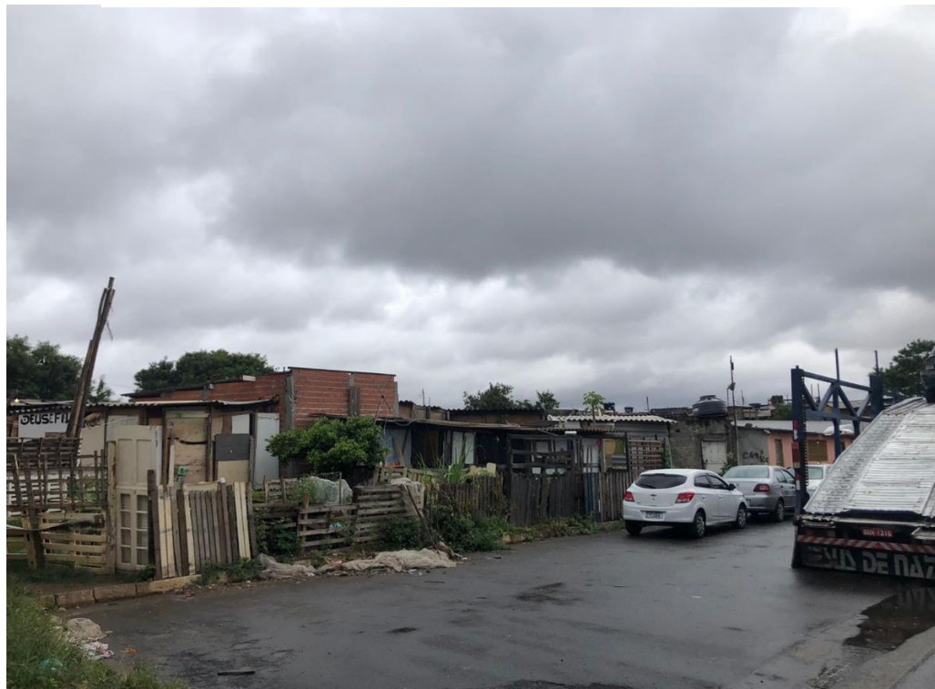
Imagem 11 – Observar que a ocupação alinhada com as calçadas.
