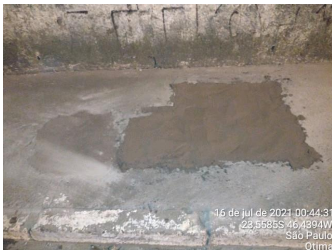
Foto 12: Vista da calçada recomposta.
