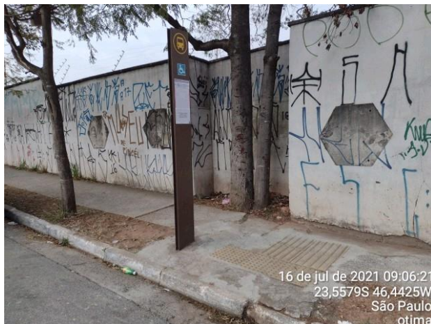
Foto 06: Visão geral do equipamento com regularização do pavimento no entorno.
