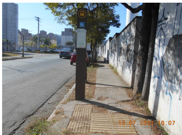
TOTEM MARROM – ALT. Nº 288 C/B ANÁLISE TÉCNICA: Regularizar o entorno do piso podotátil e do totem.
