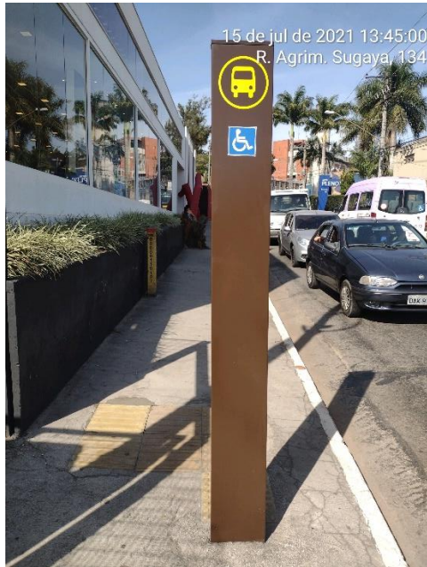
Foto 01: Vista do Totem com pichação retirada.
