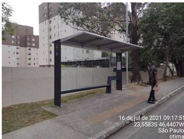
Foto 10: Visão geral do equipamento após a manutenção.
