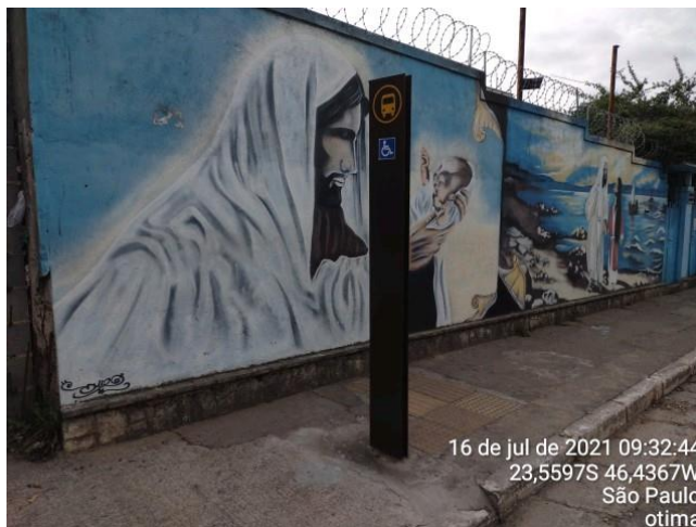
Foto 16: Detalhe da correção da pichação.
