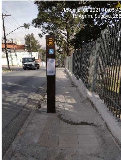
Foto 05: Vista geral do equipamento após limpeza.
