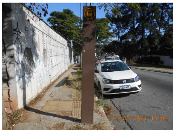
TOTEM MARROM – ALT. Nº 288 C/B ANÁLISE TÉCNICA: Regularizar o entorno do piso podotátil e do totem.
