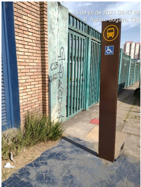
Foto 04: Retirada de pichação do equipamento.
