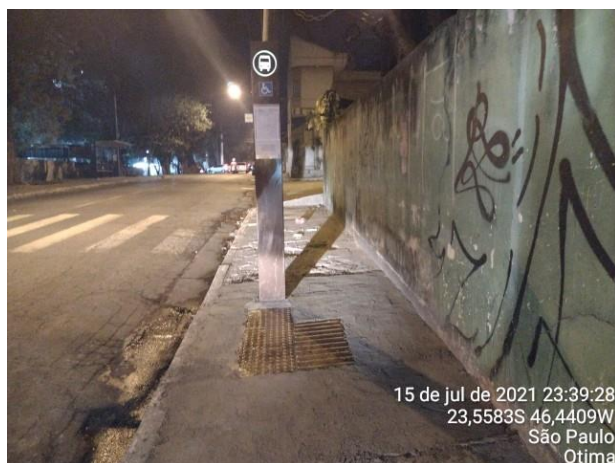
Foto 07: Visão geral do equipamento com recomposição do adesivo de itinerário.
