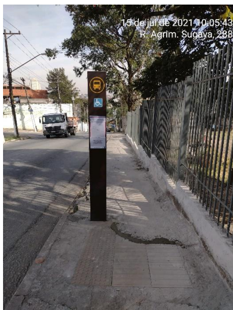
Foto 05: Vista geral do equipamento após limpeza.
