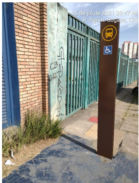
Foto 04: Retirada de pichação do equipamento.
