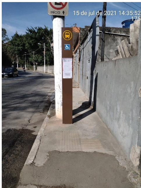
Foto 11: Visão geral do equipamento com recomposição do piso junto ao piso tátil.
