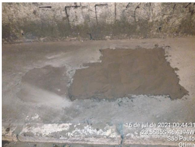
Foto 12: Vista da calçada recomposta.
