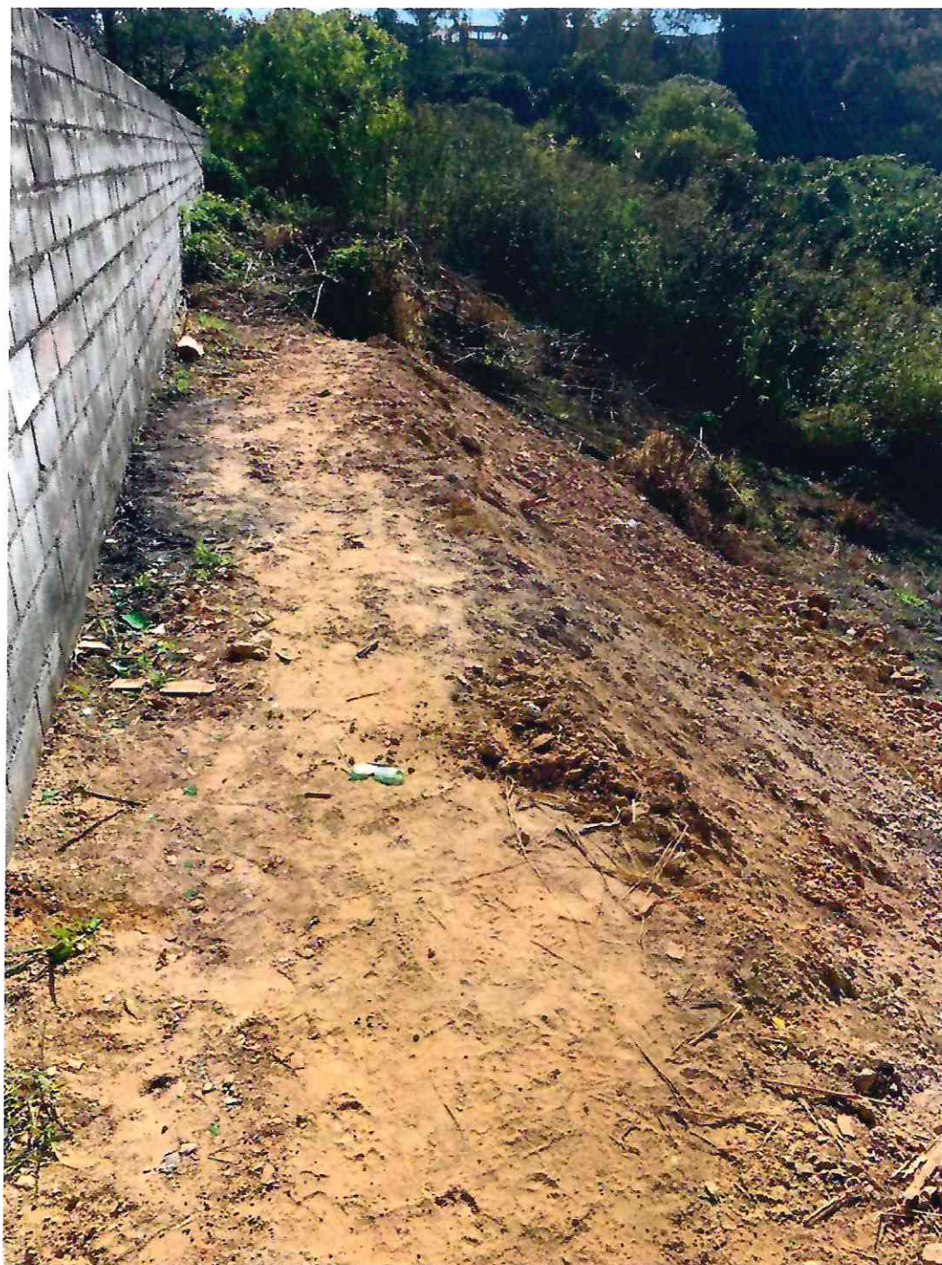
Foto 08: Vista da área interna do terreno da torre de energia onde esta sendo lançada terra.
