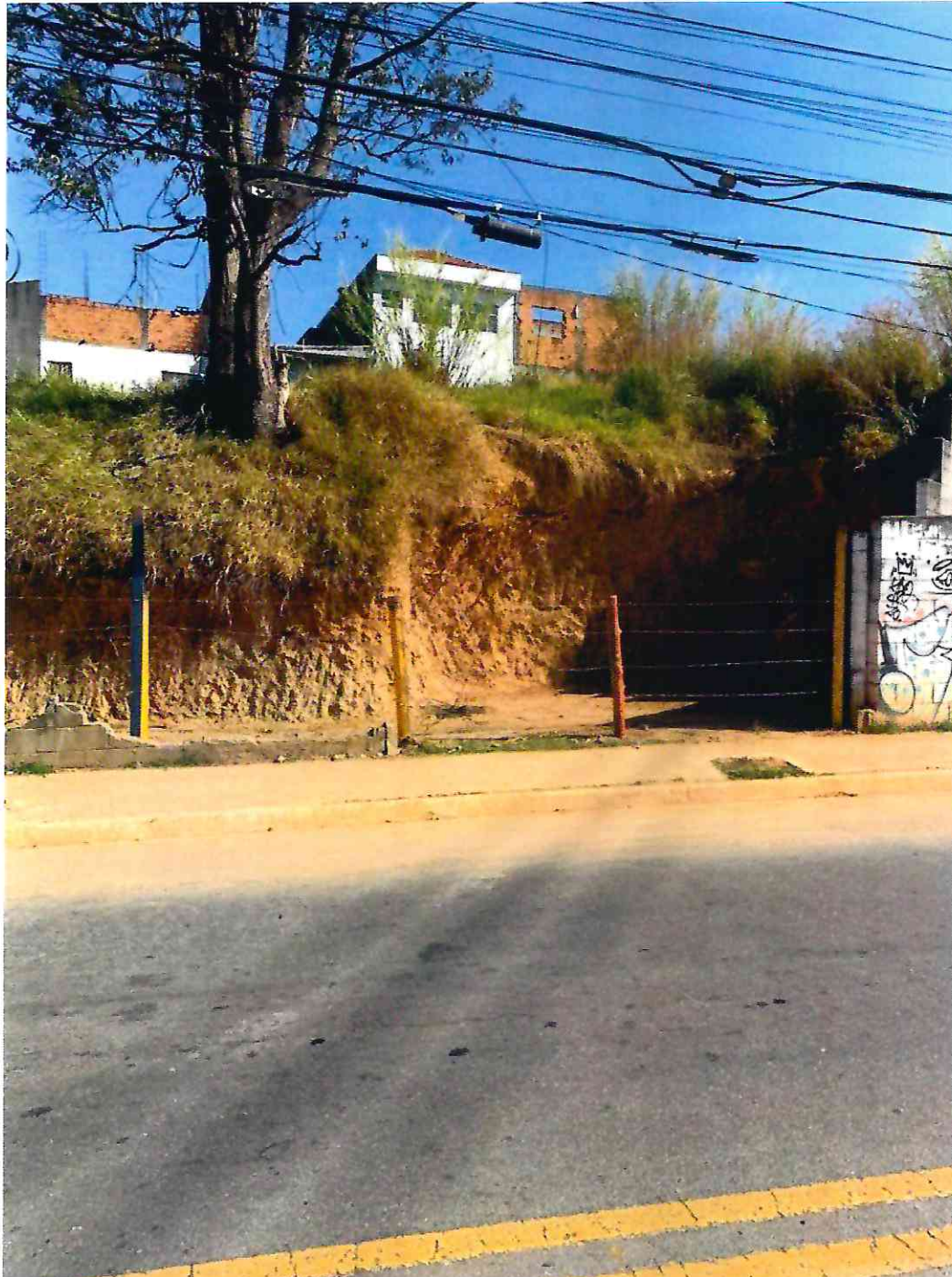
Foto 02: Vista do corte realizado em terreno na Rua Ari da Rocha Miranda com Rua Ramires Maranhão do Valê.
