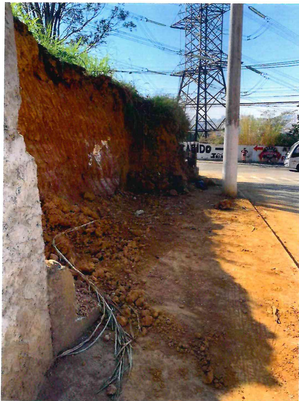
Foto 04: Vista do corte realizado em terreno na Rua Ari da Rocha Miranda com Rua Ramires Maranhão do Valê.
