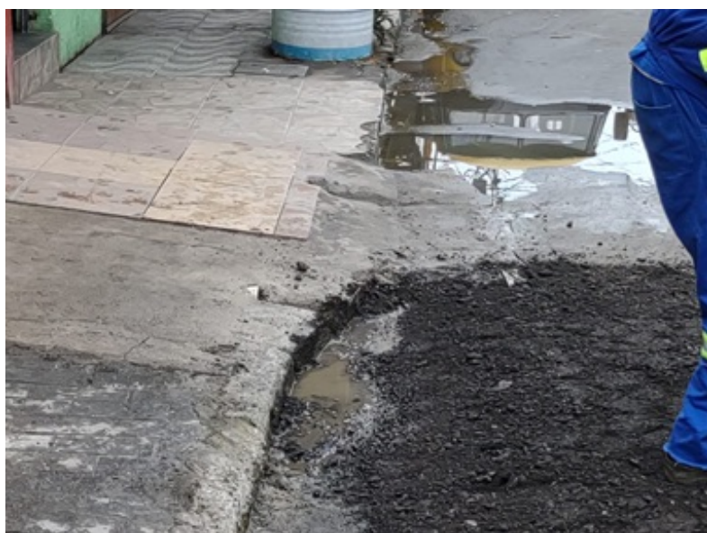
Foto 3 – Camada de regularização e compactação para receber a camada asfáltica no período noturno no dia 14/8/21.
