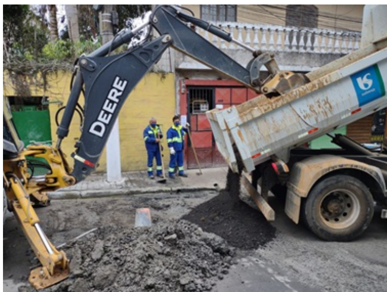
Foto 2 – Trabalhos no dia 14/8/2021.
