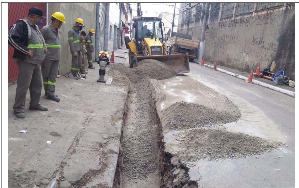
Figura 3 – Lançamento de BGS para a recomposição de vala com a utilização e cavadeira.
