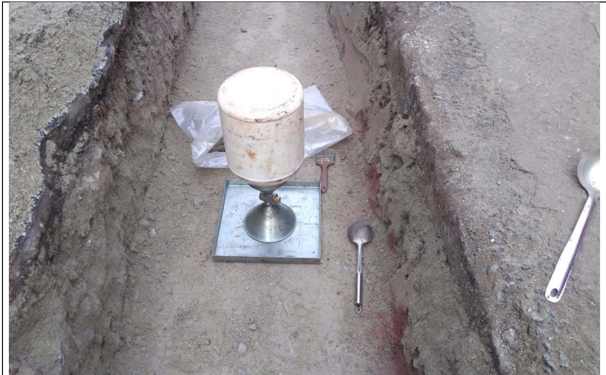
Figura 6 – Execução do ensaio de frasco de areia para a determinação da densidade in situ da camada após compactação.
