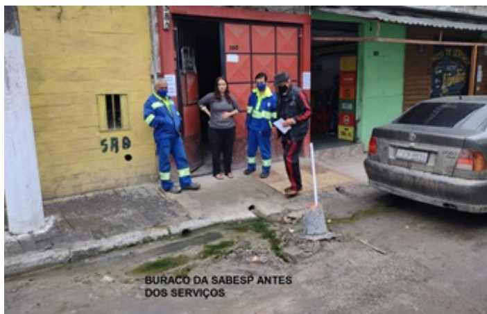
Foto 1- Chegada da Sabesp no dia 14/8/2021 para iniciar os serviços.
