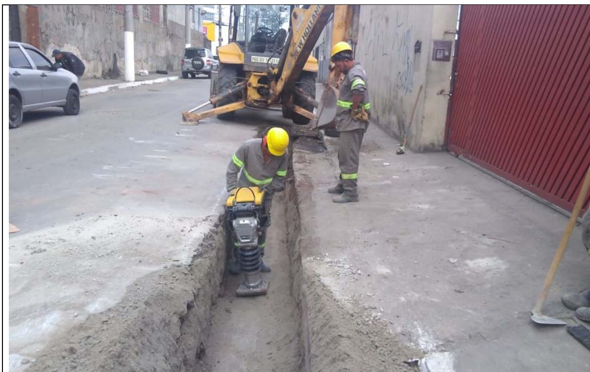
Figura 5 – Execução da compactação da camada de recomposição de vala com o auxílio de “Sapo”.
