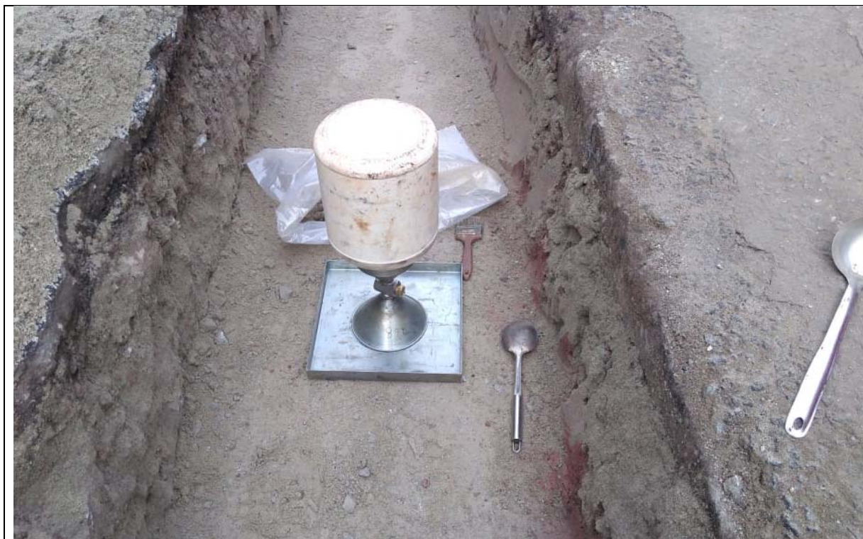
Figura 6 – Execução do ensaio de frasco de areia para a determinação da densidade in situ da camada após compactação.
