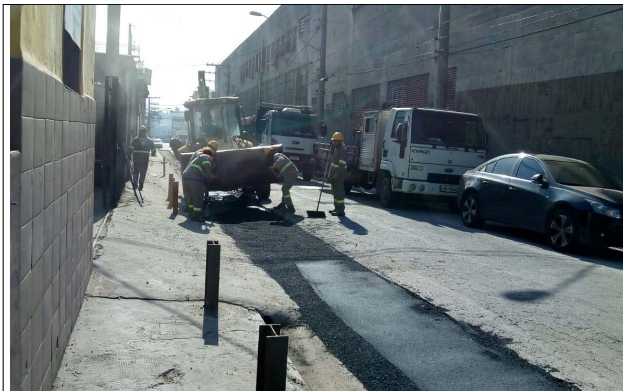
Figura 8 – Lançamento de CBUQ para a regularização da camada de rolamento.
