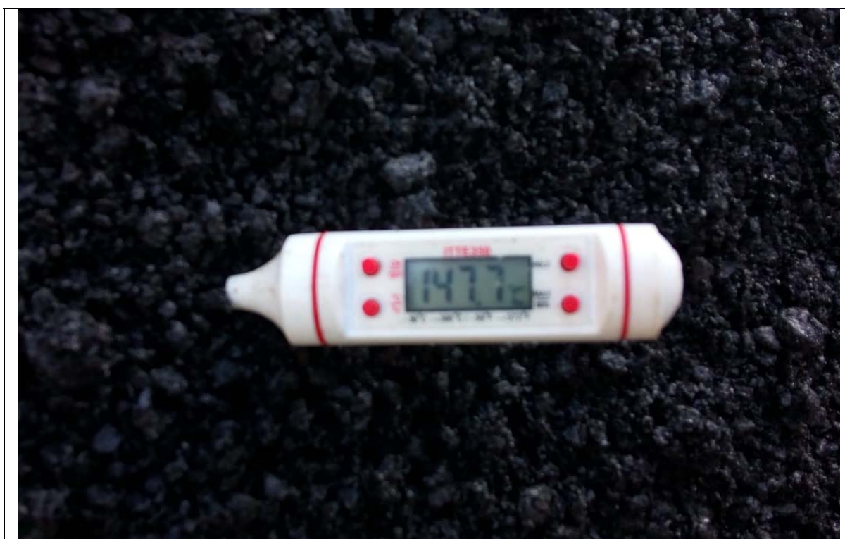
Figura 9 – Realização medição de temperatura para liberação do lançamento do CBUQ.
