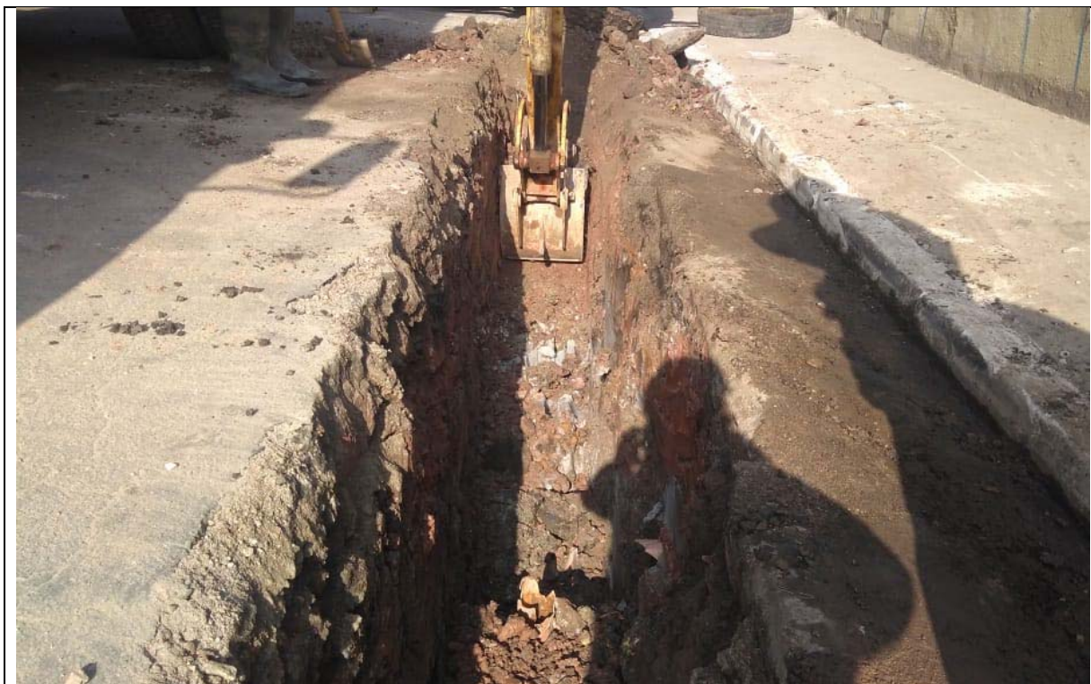
Figura 2 – Escavação de vala com a utilização de retroescavadeira.
