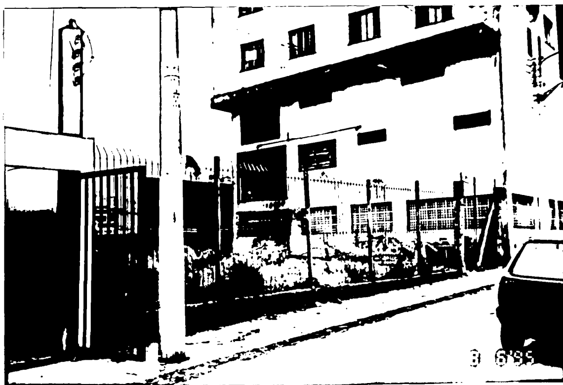
FOTO 3 - A parte fechada com o gradil é o terreno do condomínio V. Ema cedido para se abrir a via de ligação até a Avenida Salim Farah Maluf.(AR-VP) - paralela a Rua Isabel Garcia.
