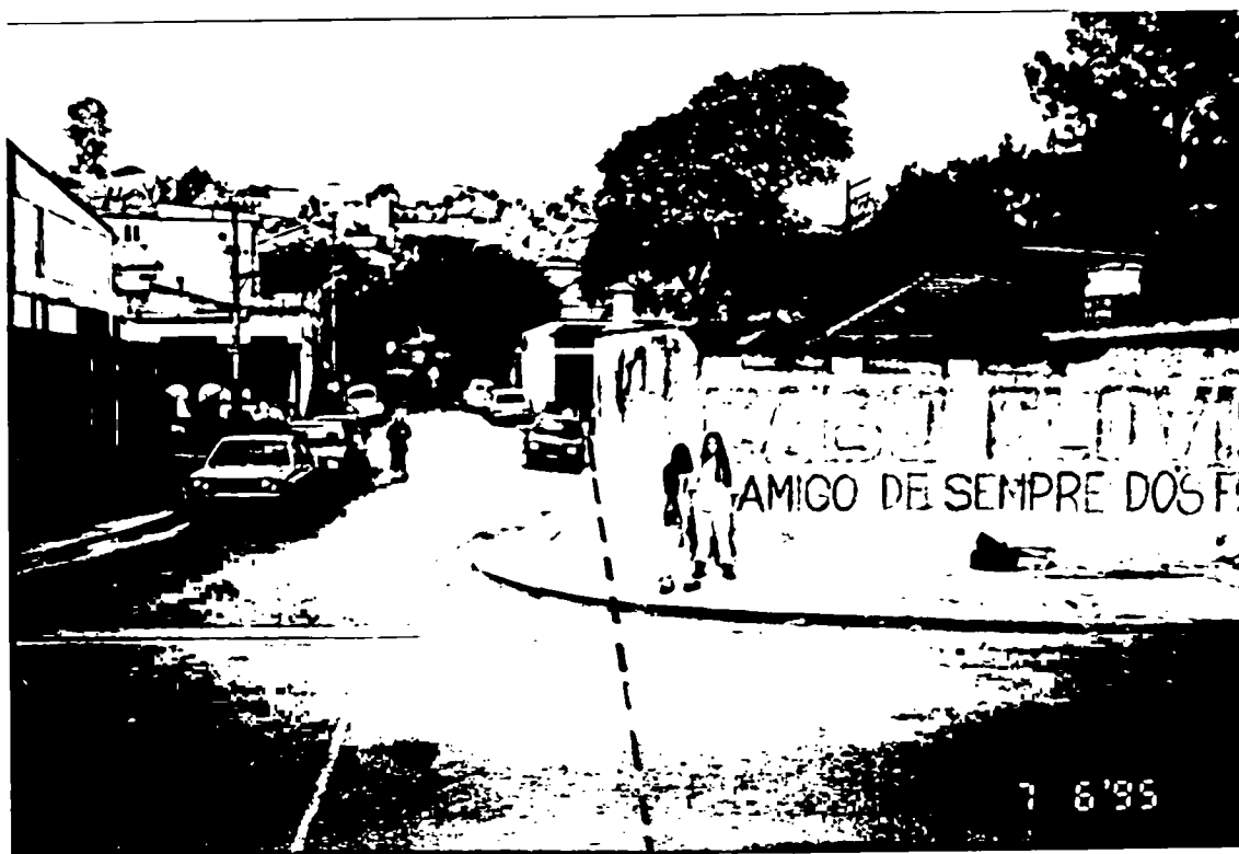
FOTO 05 - Vista do trecho a ser alinhado onde vemos os fundos (à direita) do terreno que terá parte desapropriado. Ao fundo o cruzamento com a Rua Inácio Mammana.
