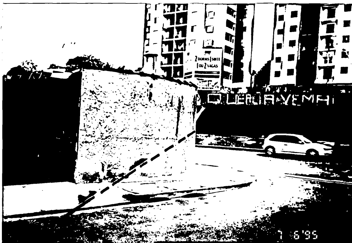
FOTO 03 - Parte do terreno a ser desapropriado.
