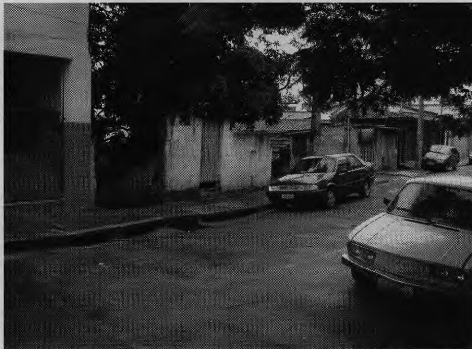
Trecho da Rua Itagiba onde esta previsto a conexão com viela sanitária.
