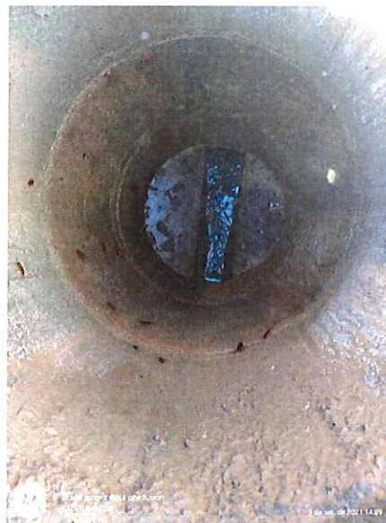
Figura 4 – Poço de Visita limpo
