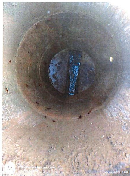
Figura 4 – Poço de Visita limpo
