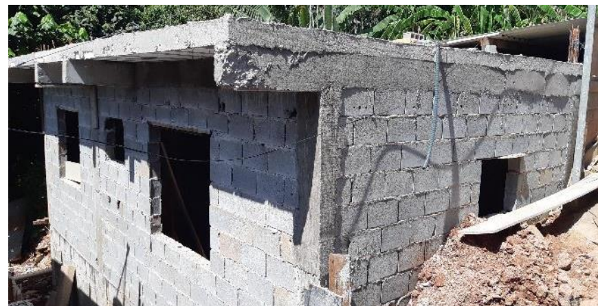
Imagem 26: Construção no interior do assentamento. Data: Março de 2021. Fonte: Acervo Sehab
