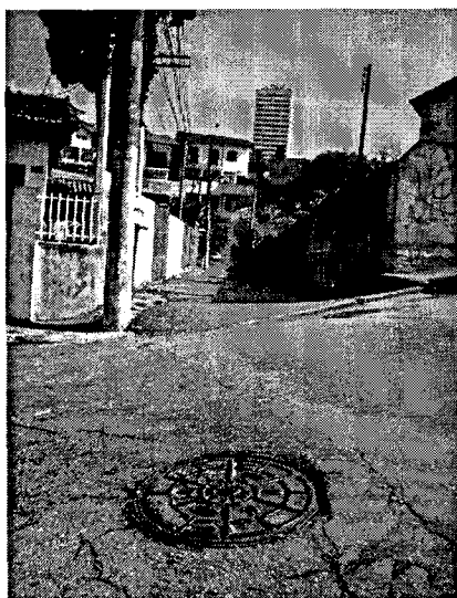
Foto 03 – galeria existente implantada na viela, a ser conectada pela servidão proposta (lote do lado direito corresponde ao terreno retratado pela foto 03).
