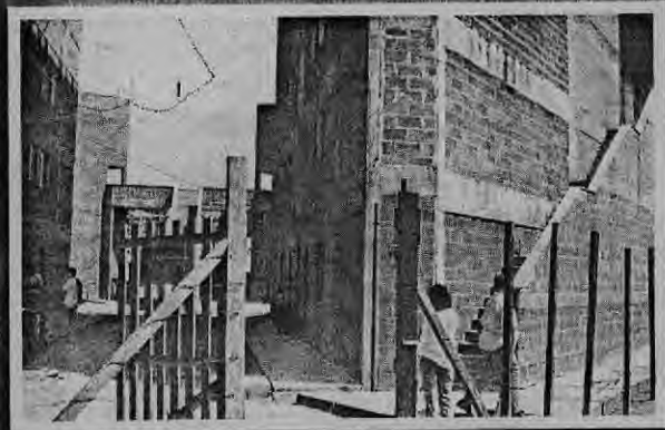
Prédio onde fica o Centro Maria Miguel.
