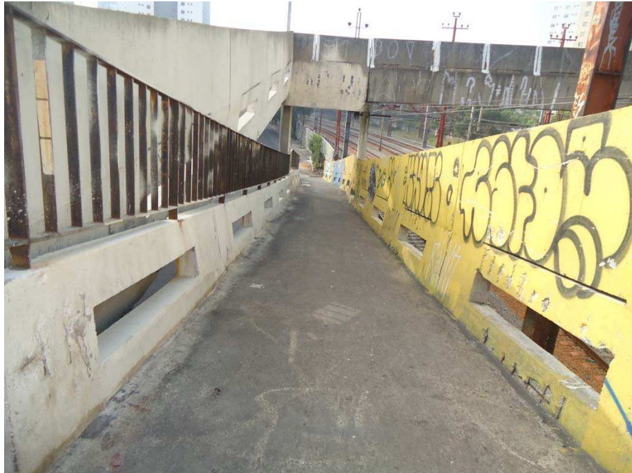
FOTO 11 – Rampa lado Rua Luigi Greco. Notar trecho do prolongamento da travessia principal.
