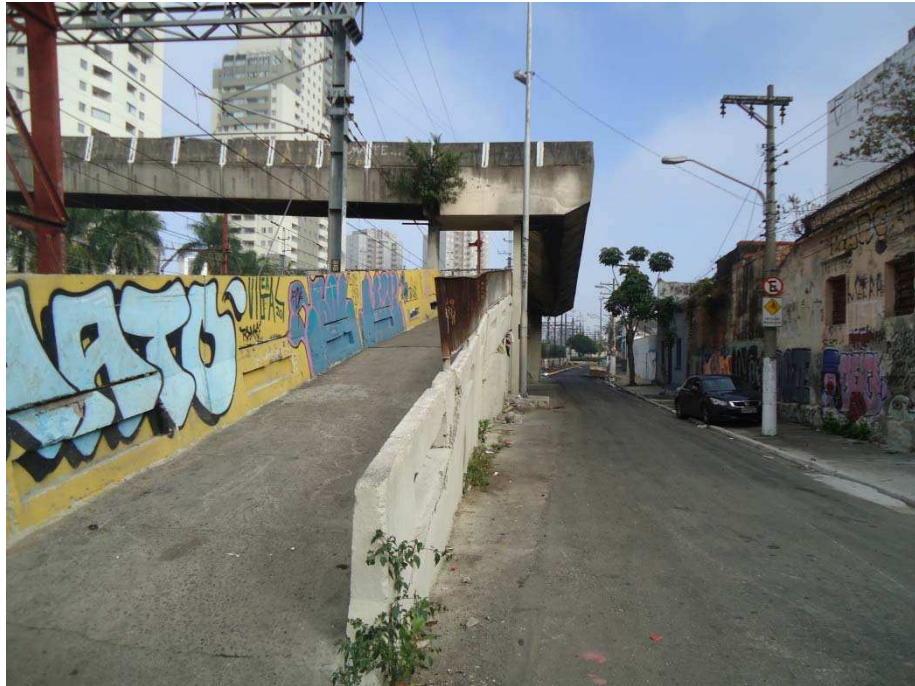
FOTO 3 – Início da rampa lado Rua Luigi Greco
