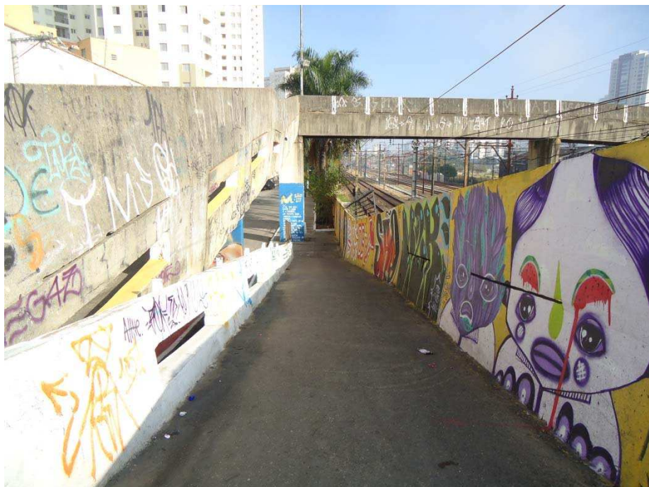
FOTO 14 – Rampa de acesso lado Rua Capistrano de Abreu.
