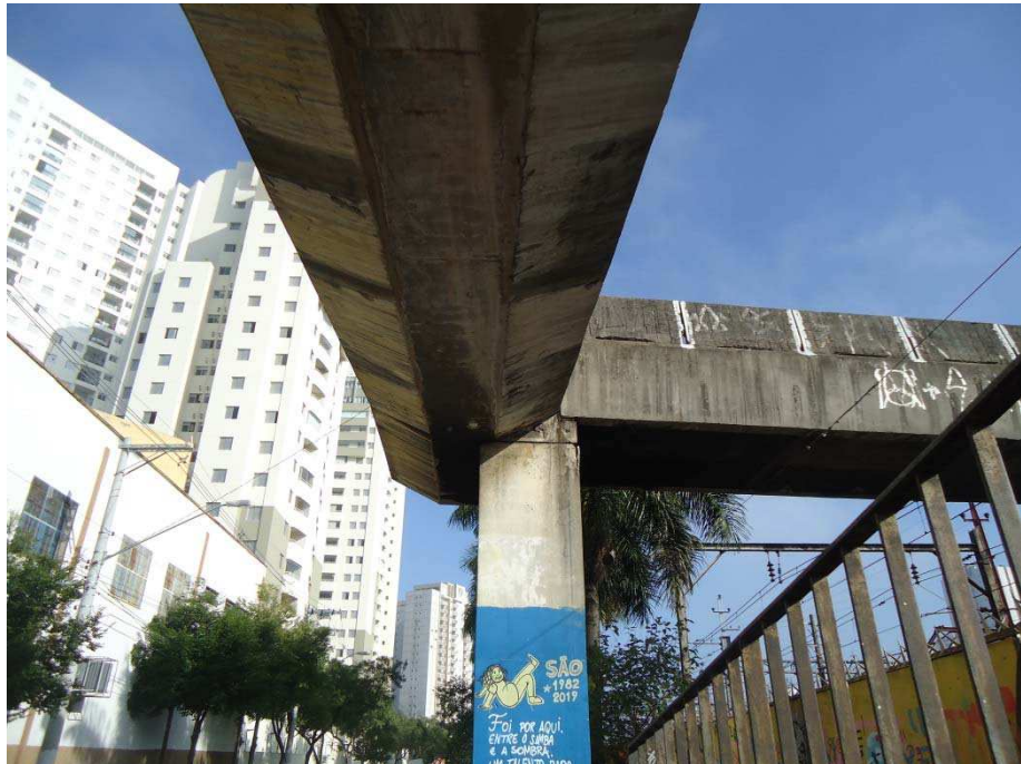
FOTO 18 – Viga-rampa lado Rua Capistrano de Abreu
