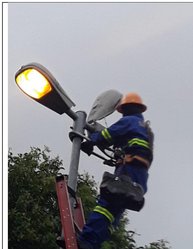
Rua Ipubi e Rua Tamboara
