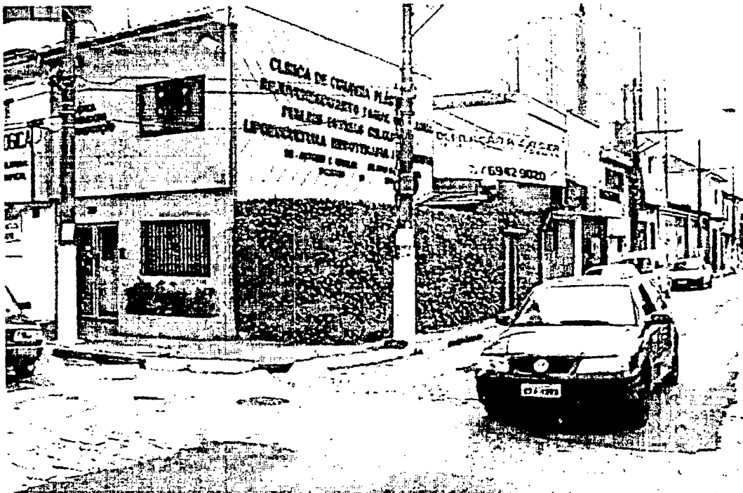
Vista do imóvel da Municipalidade na esquina, com as paredes coberta por vegetação
