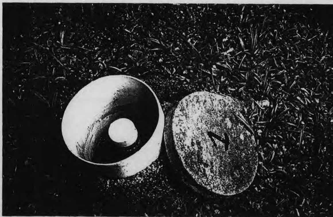
Vê-se a parte superior do P1, hermeticamente plugada sem o tampão protetor.
