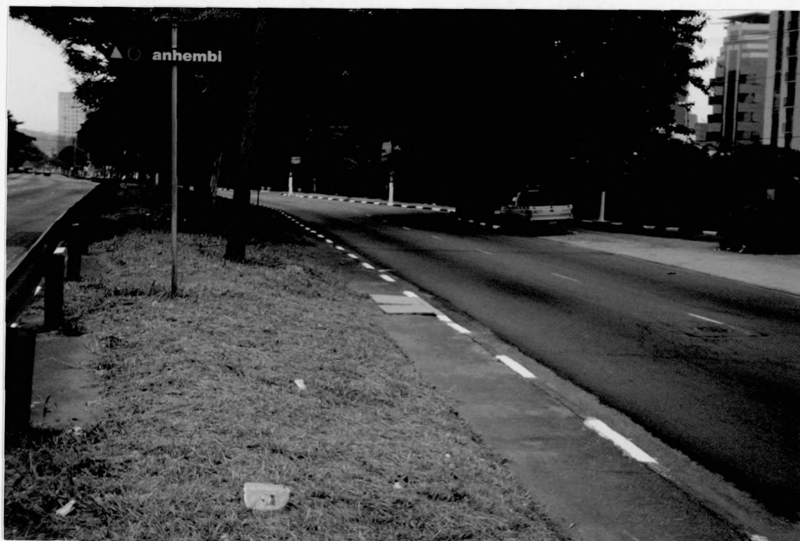
CORREDOR AV. BANDEIRANTES
