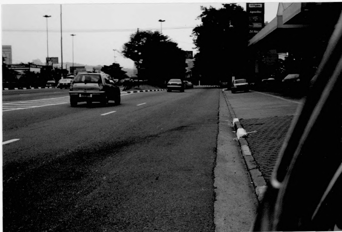
ALTURA DO Nº 900 DA AV. BANDEIRANTES
