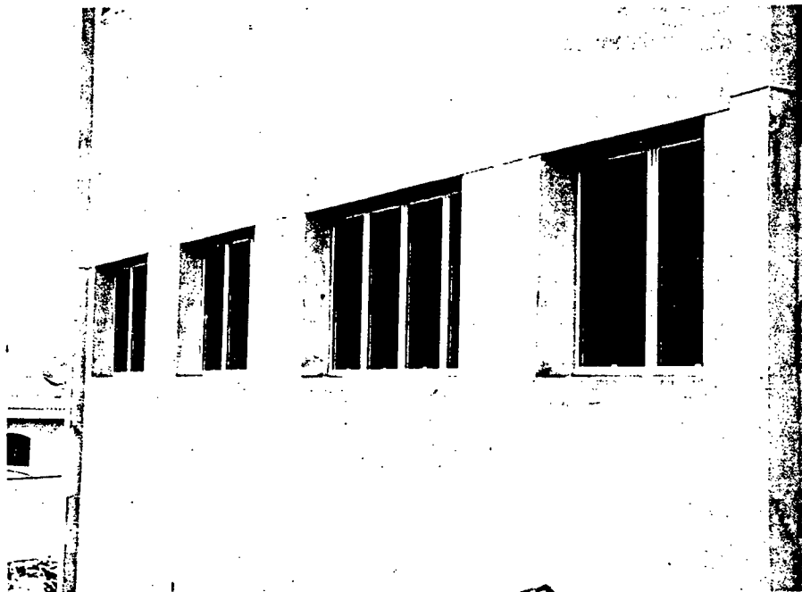
Foto 33 – Revestimento de fachada pronto com os caixilhos colocados
