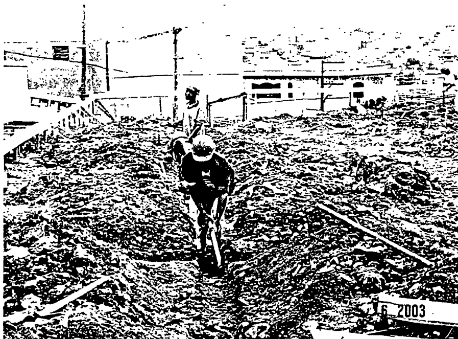
Foto 10 – Escavação de blocos e vigas baldrame
