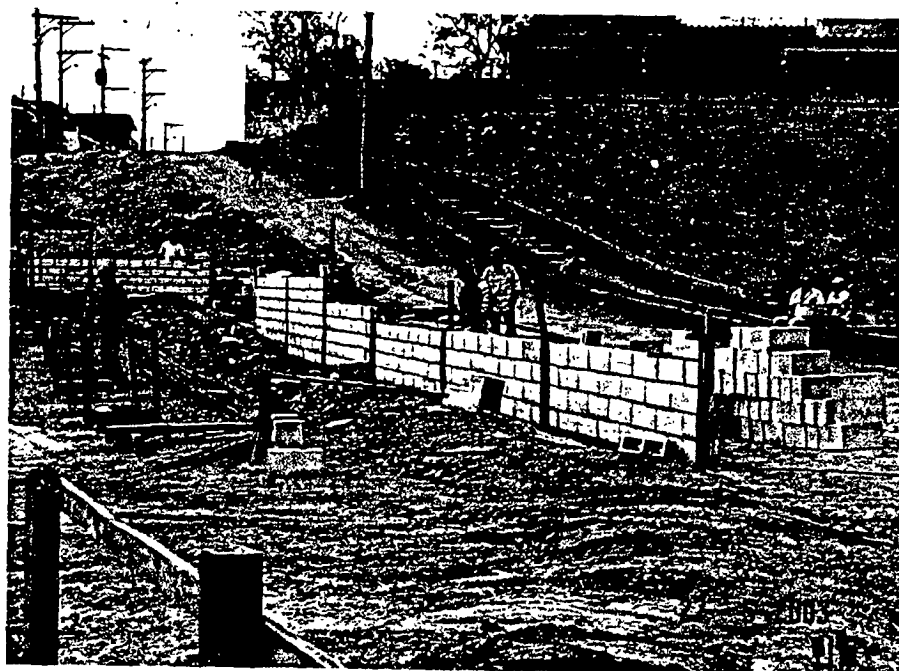
Foto 7 - Execução dos muros de divisa
