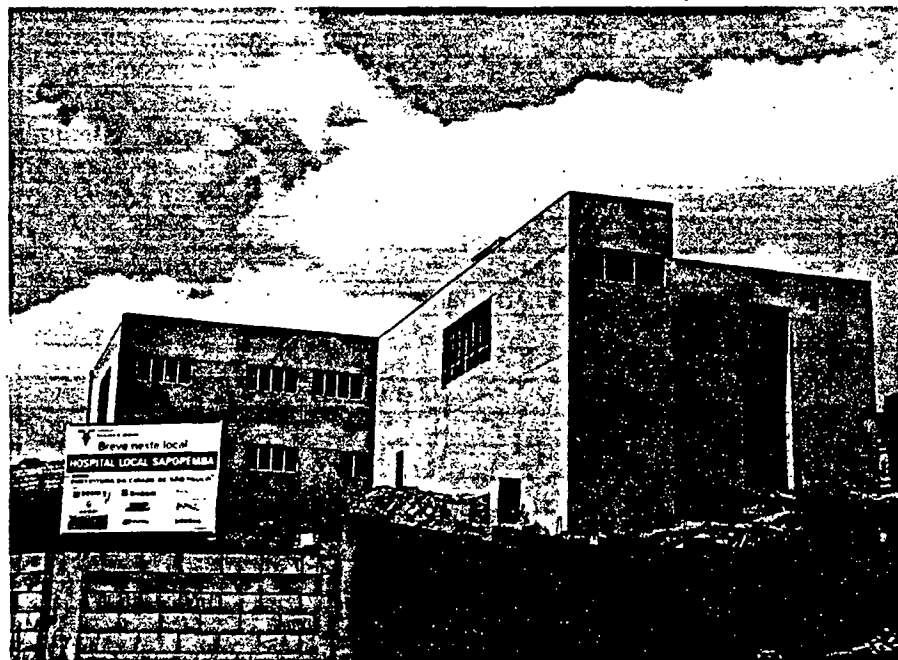
Foto 42 – Panorama geral da obra
