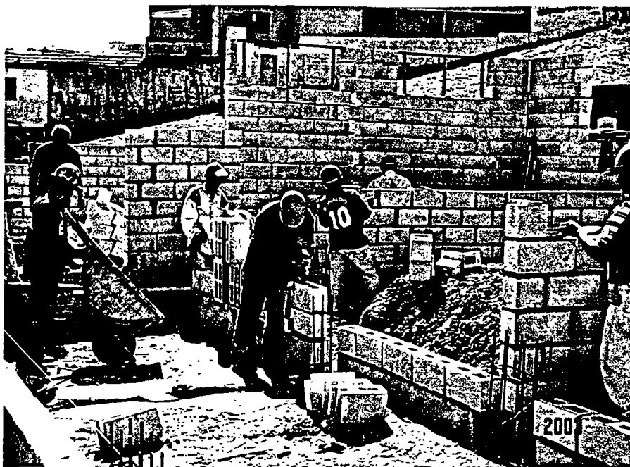
Foto 14 – Elevação da alvenaria do térreo
