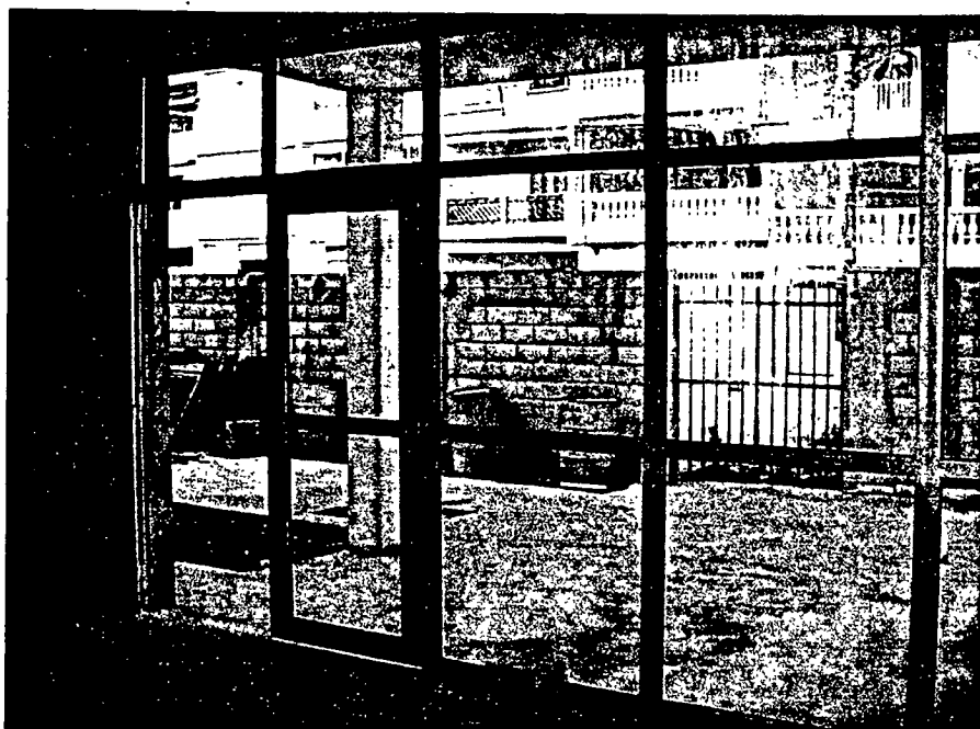
Foto 51 – Caixilho (porta de entrada) com o vidro colocado
