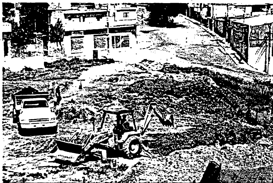
Foto 2 – Início dos serviços de desvio da galeria de águas pluviais
