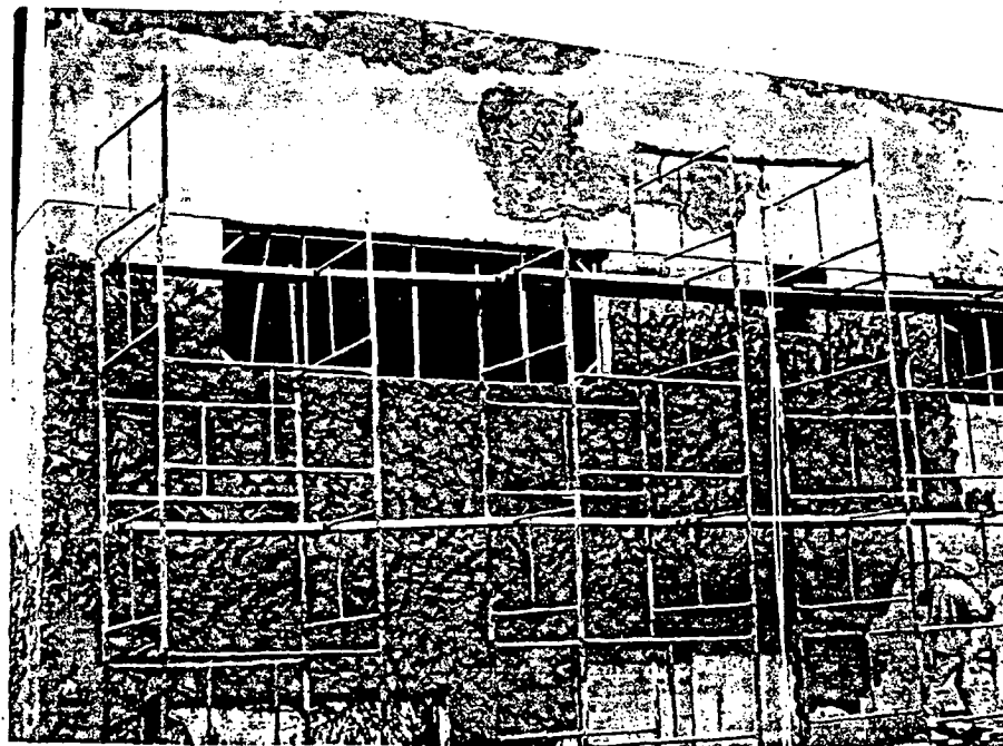
Foto 24 – Execução dos revestimentos de fachada
