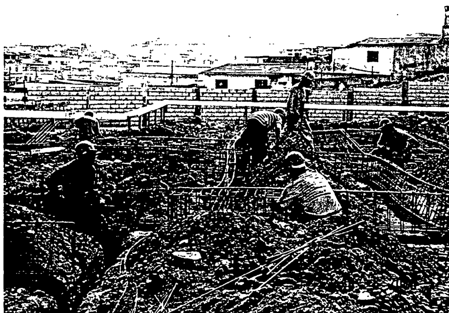
Foto 11 – Armação dos blocos e vigas baldrame
