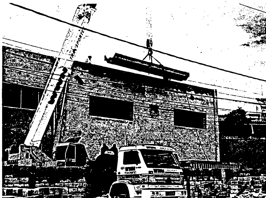
Foto 35 – Içamento das telhas para cobertura
