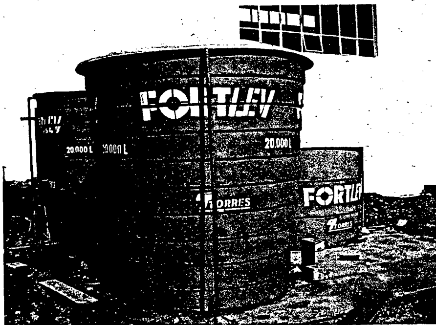
Foto 48 – Reservatório inferior colocado sob a base
