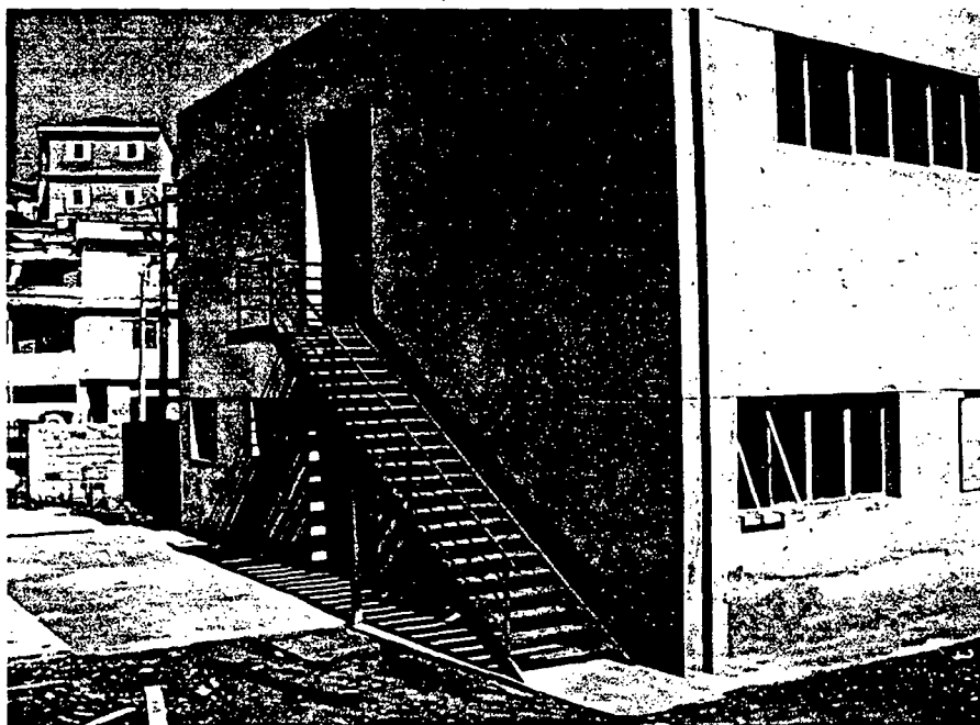
Foto 44 – Serralheria – Escada de emergência
