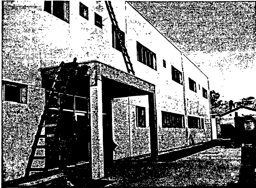
Foto 49 – Aplicação do selador na fachada
