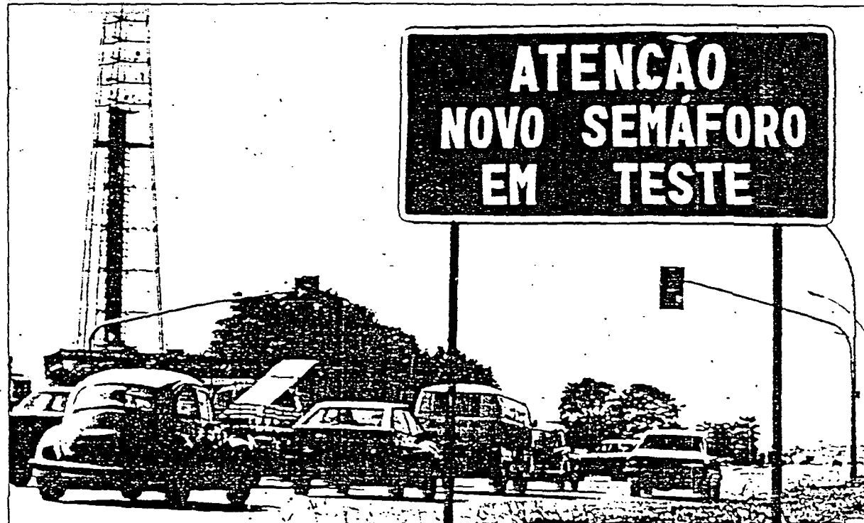
Instalado no Eixo Monumental, o sinal tem duas fileiras de luzes verdes e vermelhas para controlar a velocidade.
