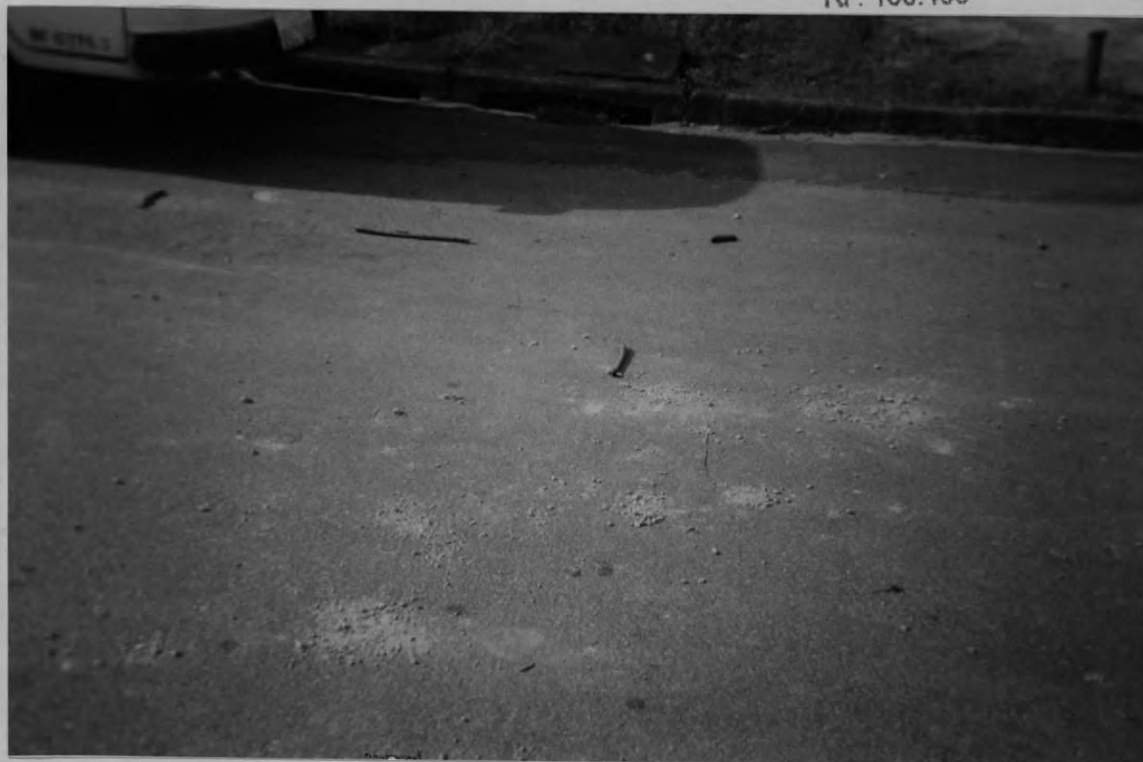
Foto nº 01 - Rua Parque do Lago 550
