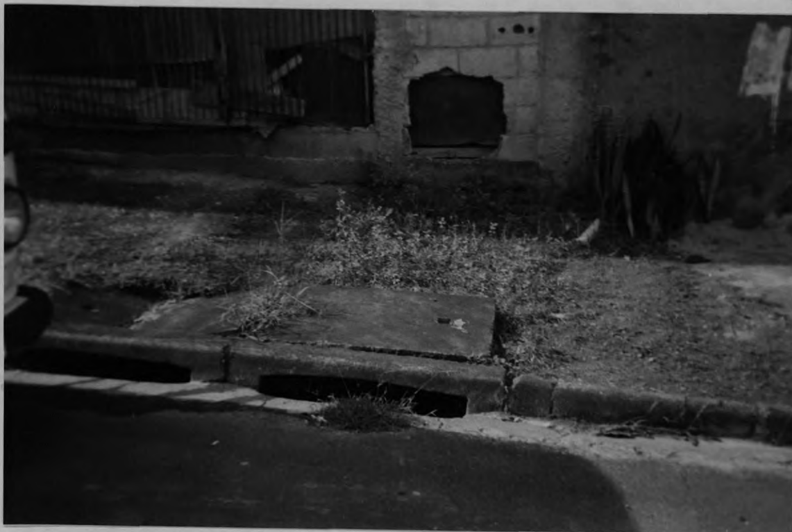
Foto nº 03 - Rua Parque do Lago 550
