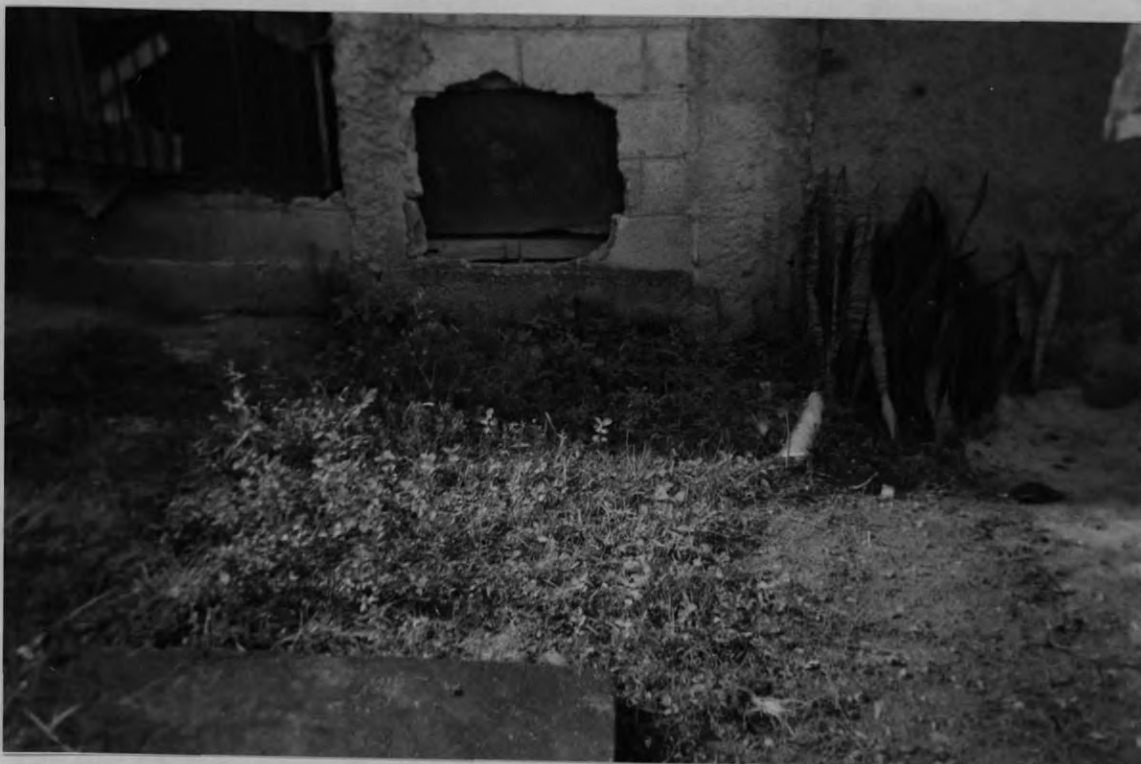
Foto nº 04 - Rua Parque do Lago 550
