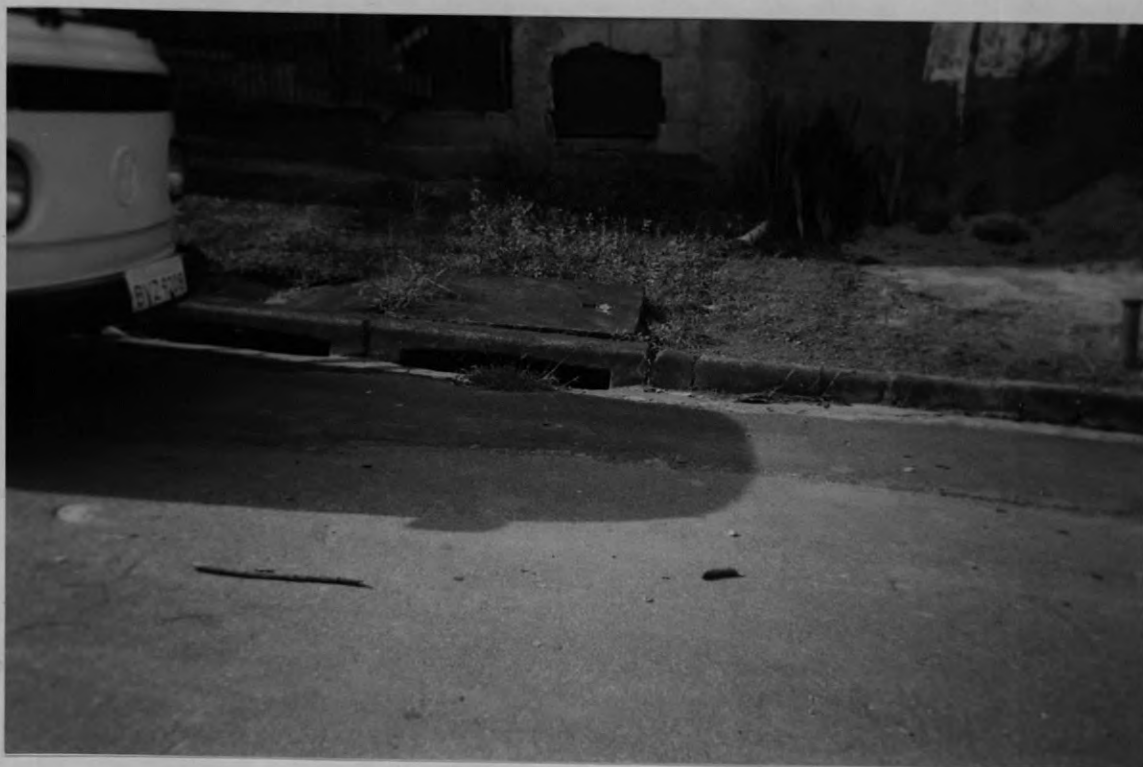
Foto nº 02 - Rua Parque do Lago 550
