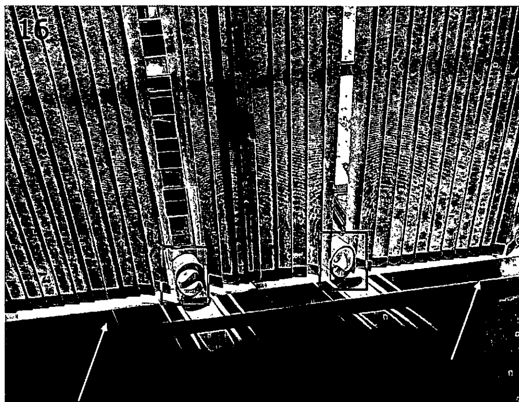
CORTINAS ressalva-se ~10 elementos necessitando reinstalação.
