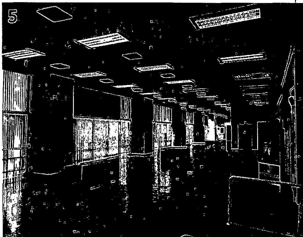
FORRO DE GESSO, LUMINÁRIAS e DIFUSORES (ar cond.), PISO e PINTURA: tudo em estado de novo, idem portas.
