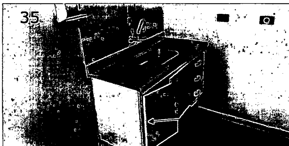
COPA - pia e gabinete em bom estado - necessário ajustar as molas da porta do gabinete
