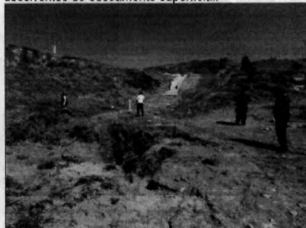
Foto 12 – Solo exposto com ocorrência de processos erosivos, desencadeados pelo escoamento superficial.
