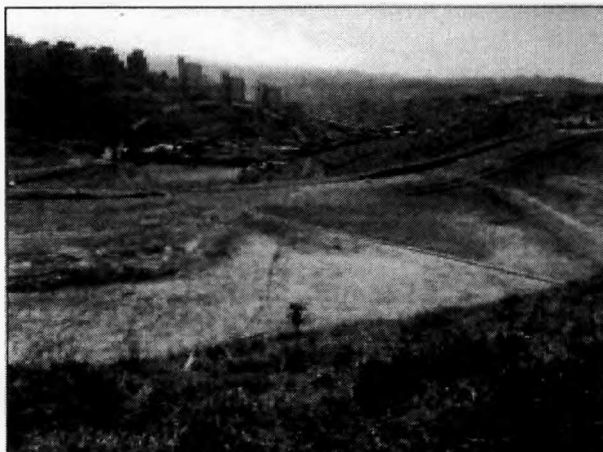
Foto 07 – Vista geral da faixa de dutos já em processo de recuperação. Ao fundo, em destaque a comunidade Morumbizinho, localizada a jusante da faixa.
