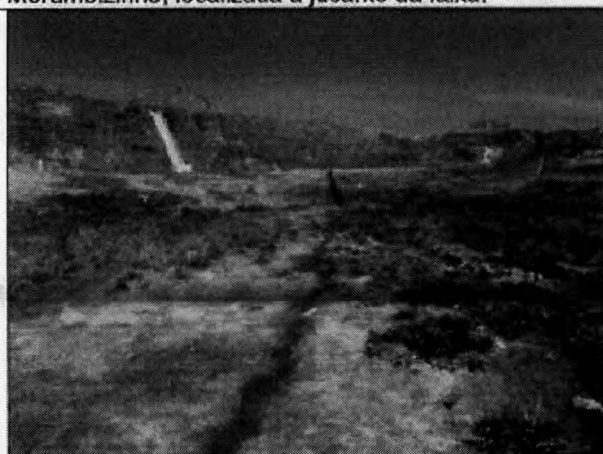
Foto 09 – Campo aberto localizado entre a área da faixa de dutos e a comunidade Morumbizinho, para onde são direcionadas as águas captadas pela faixa. Ao fundo, em destaque, as duas escadas hidráulicas instaladas no talude da faixa.
