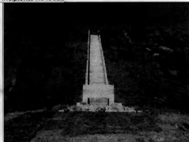
Foto 10 – Escada hidráulica com dissipador de energia instalada no talude da faixa. Notar a ausência de cobertura vegetal nas laterais da escada, bem como evidências de ocorrência de erosões laminares decorrentes do escoamento superficial.
