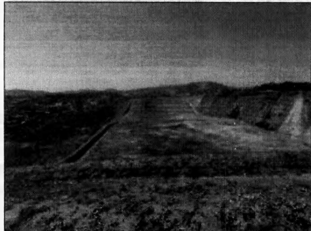
Foto 05 – Vista geral da faixa de dutos já em processo de recuperação, com cobertura vegetal incipiente e instalação de sistema de drenagem definitivo.
