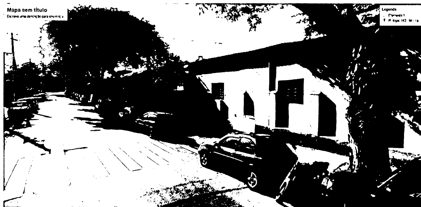
ALMOXARIFADO SMADS - FACHADA - IMÓVEL 3605
