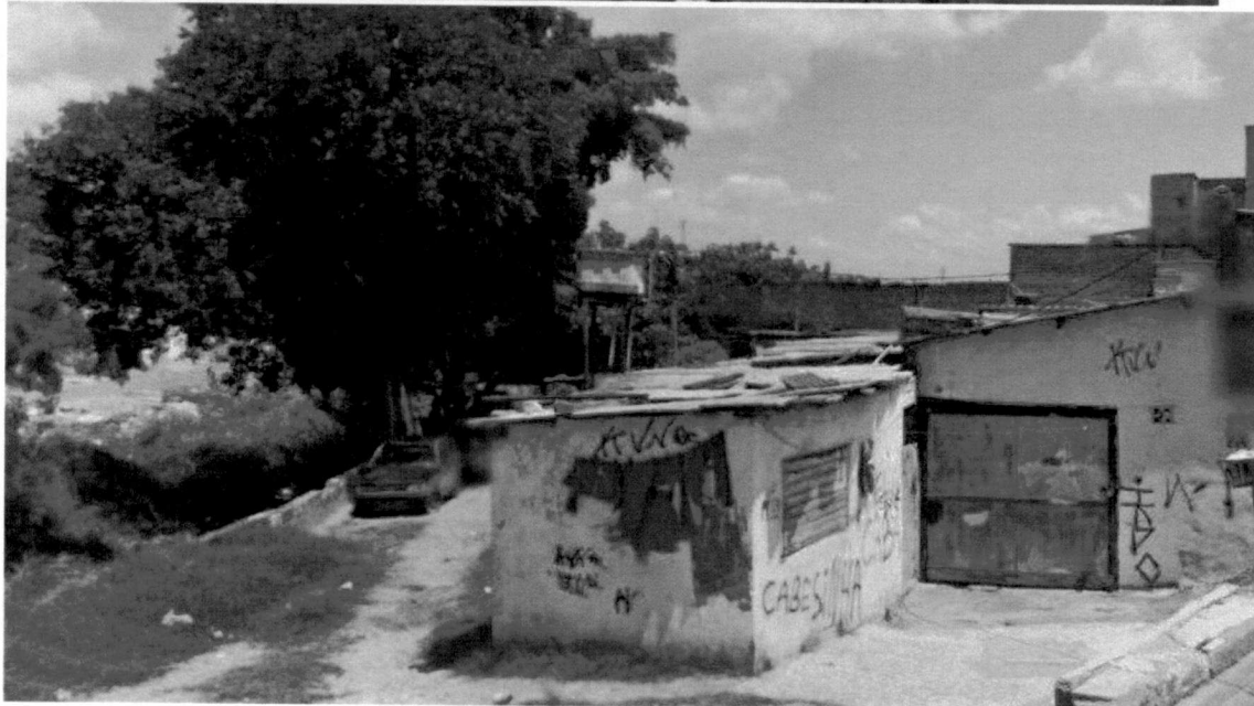
Imagem 03: Vista geral de algumas moradias proximas ao córrego. (Fonte Google Earth)
