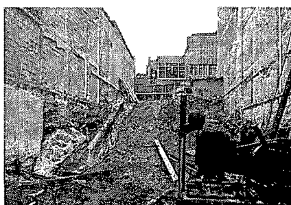
Figura 7: Área aterrada com os elementos de demolição, vista da rua dos Aflitos para a rua Galvão Bueno.
