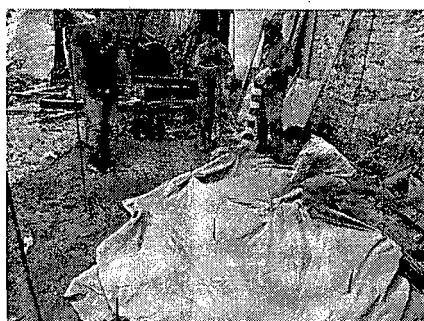
Figura 54: Encerramento da trincheira e unidades de escavação com manta geotêxtil.
