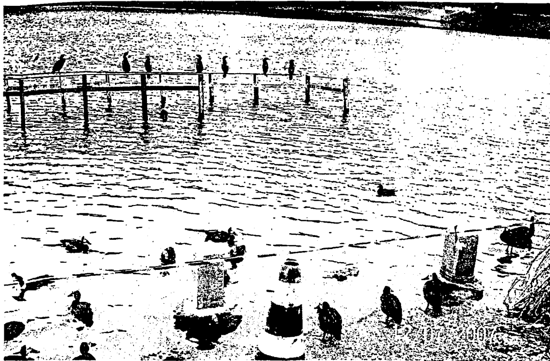
Foto 11 – Outra vista do deck de madeira arrancado dos seus pilares de apoio em uma chuva intensa ocorrida no início do ano. Foto obtida em 12/07/2007.
