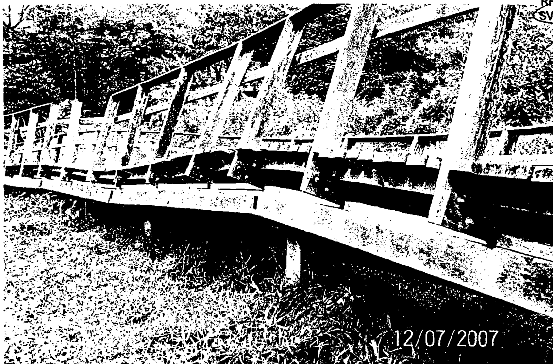
Foto 33 – Outra vista da passarela. Vê-se nesta imagem a viga longarina rotacionada em suas emendas, fora dos pilares de apoio, deformando assim o tabuleiro acima dela. Foto obtida em 12/07/2007.
