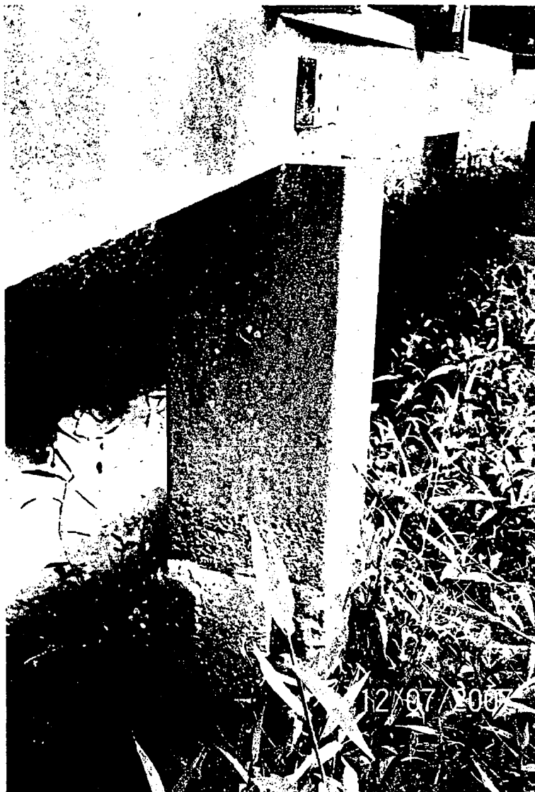
Foto 31 – Mais uma vista de outro pilar de concreto da passarela de madeira colapsada. Vê-se claramente a inexistência de uma fixação adequada entre o pilar e a superestrutura de madeira. Note-se a forma irregular do bloco de concreto de transição entre a estaca e o pilar, apresentando inclusive danos em seu revestimento. Foto obtida em 12/07/2007.
