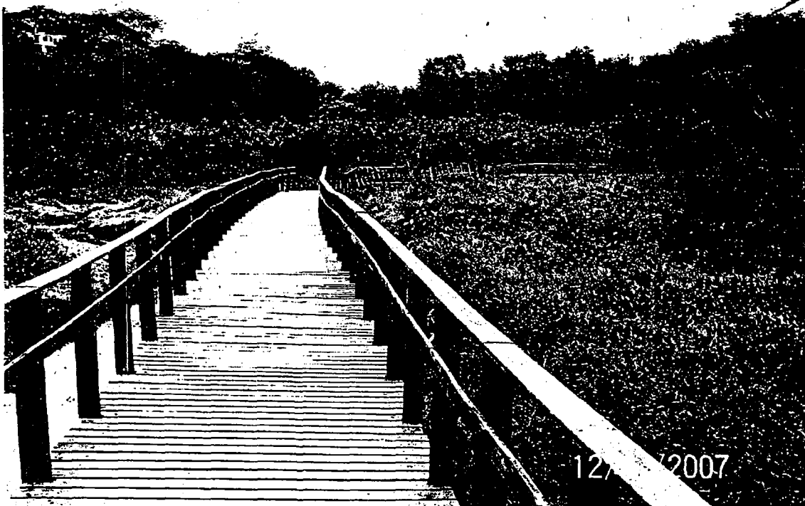
Foto 20 – Vista de um trecho relativamente preservado da passarela de madeira colapsada. Foto obtida em 12/07/2007.
