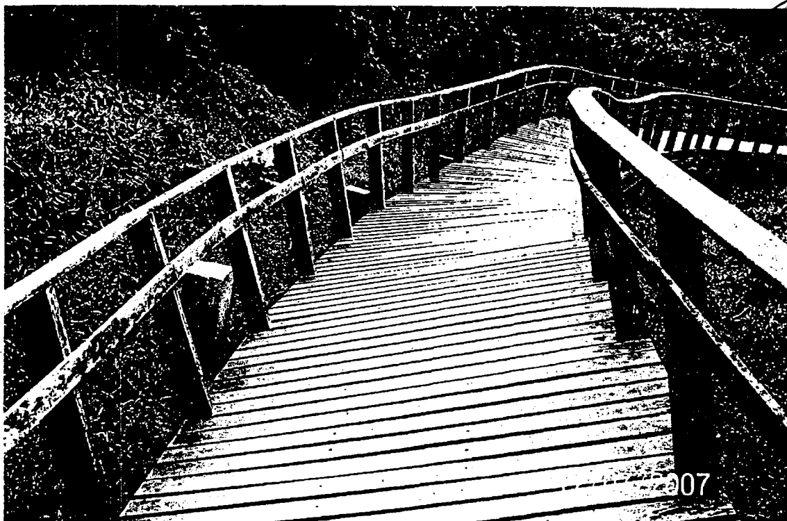
Foto 25 – Outro trecho da passarela de madeira colapsada, exibindo vários pilares sem qualquer tipo de amarração. Foto obtida em 12/07/2007.
