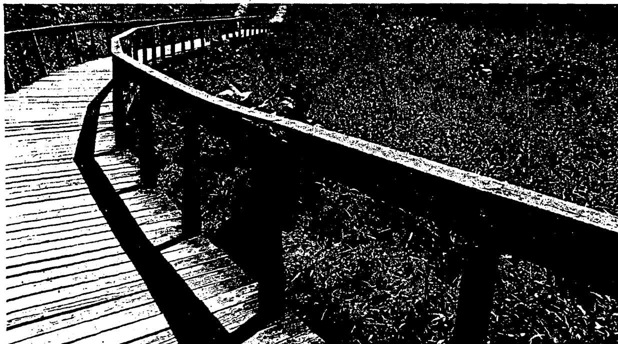
Foto-7 Vista de um trecho do guarda - corpo a ser recuperado
