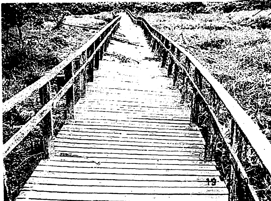
Foto 05 – Outro trecho da passarela de madeira colapsada, em decorrência da falta de amarração entre a super e a infraestrutura da mesma. Note-se, à direita da foto, que as peças de madeira do assoalho apresentam diferenças nas suas dimensões. Foto obtida em 19/03/2007.
