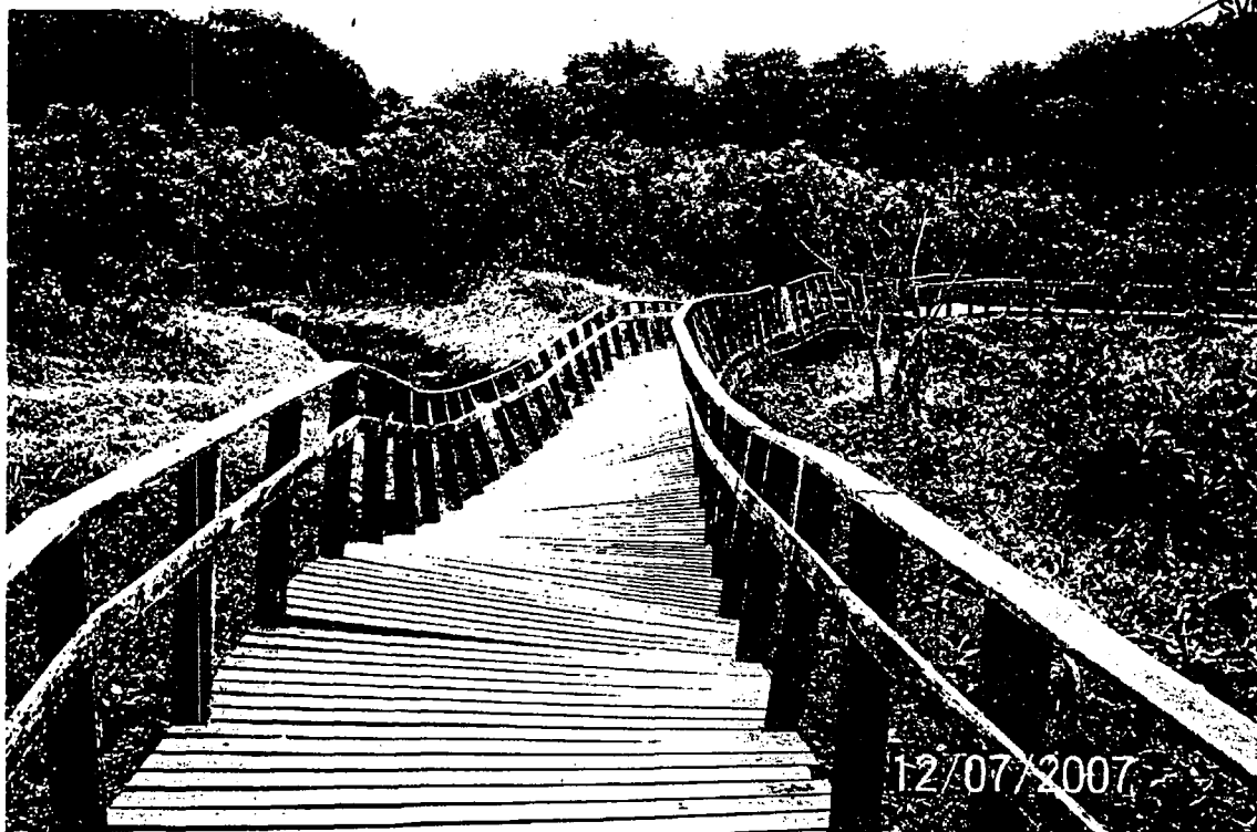
Foto 23 – Vista de um trecho bastante comprometido da passarela de madeira colapsada. Foto obtida em 12/07/2007.
