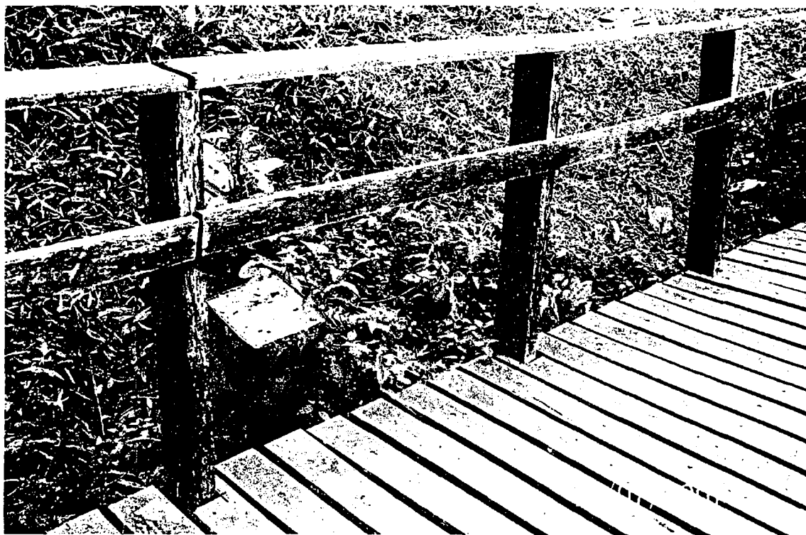
Foto 24 – Em outro ponto da passarela de madeira colapsada, vê-se um dos pilares que a apoiavam. Vê-se claramente a ausência de qualquer tipo de amarração entre o pilar e a superestrutura de madeira. Foto obtida em 12/07/2007.
