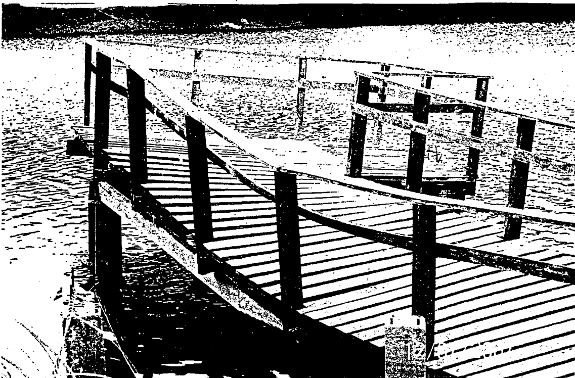
Foto 14 – Ainda outra vista, mais próxima, do deck de madeira arrancado dos seus pilares de apoio em uma chuva intensa ocorrida no início do ano. Foto obtida em 12/07/2007.
