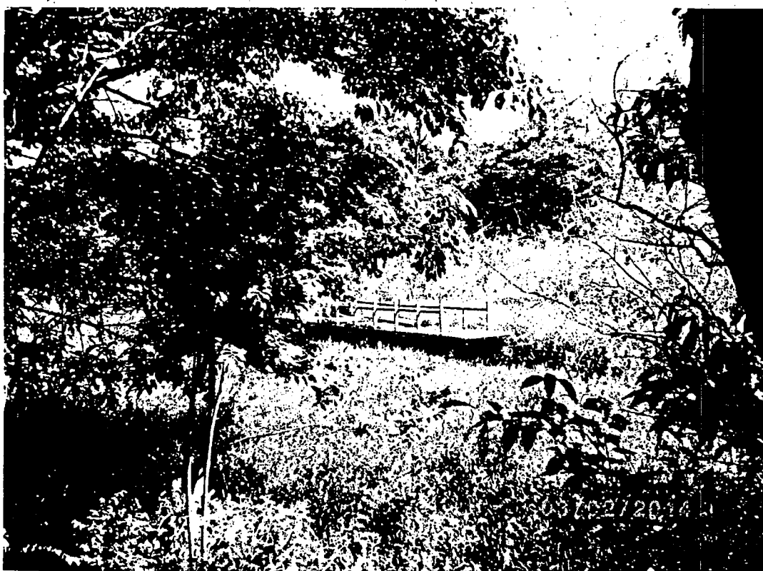
Fotos 18 e 19 – Vistas da trilha com partes restantes danificadas da passarela 2 ao fundo
