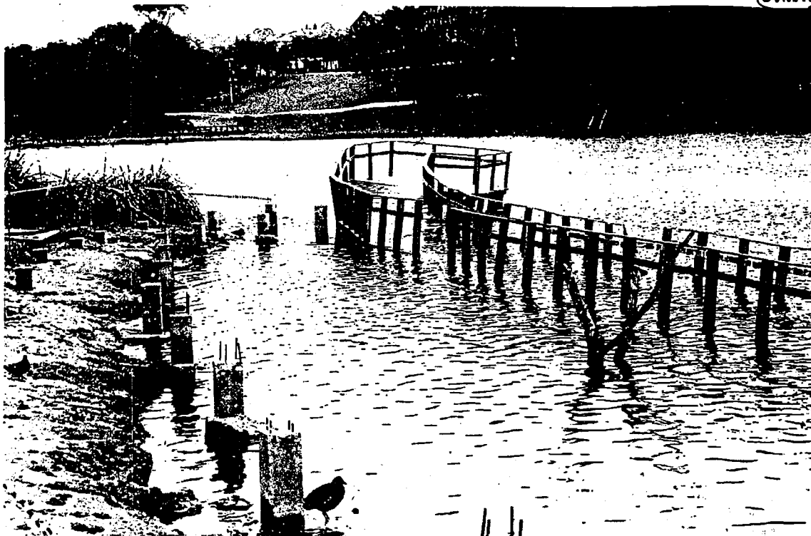
Foto 13 – Outra vista do deck de madeira arrancado dos seus pilares de apoio em uma chuva intensa ocorrida no início do ano. Foto obtida em 12/07/2007.
