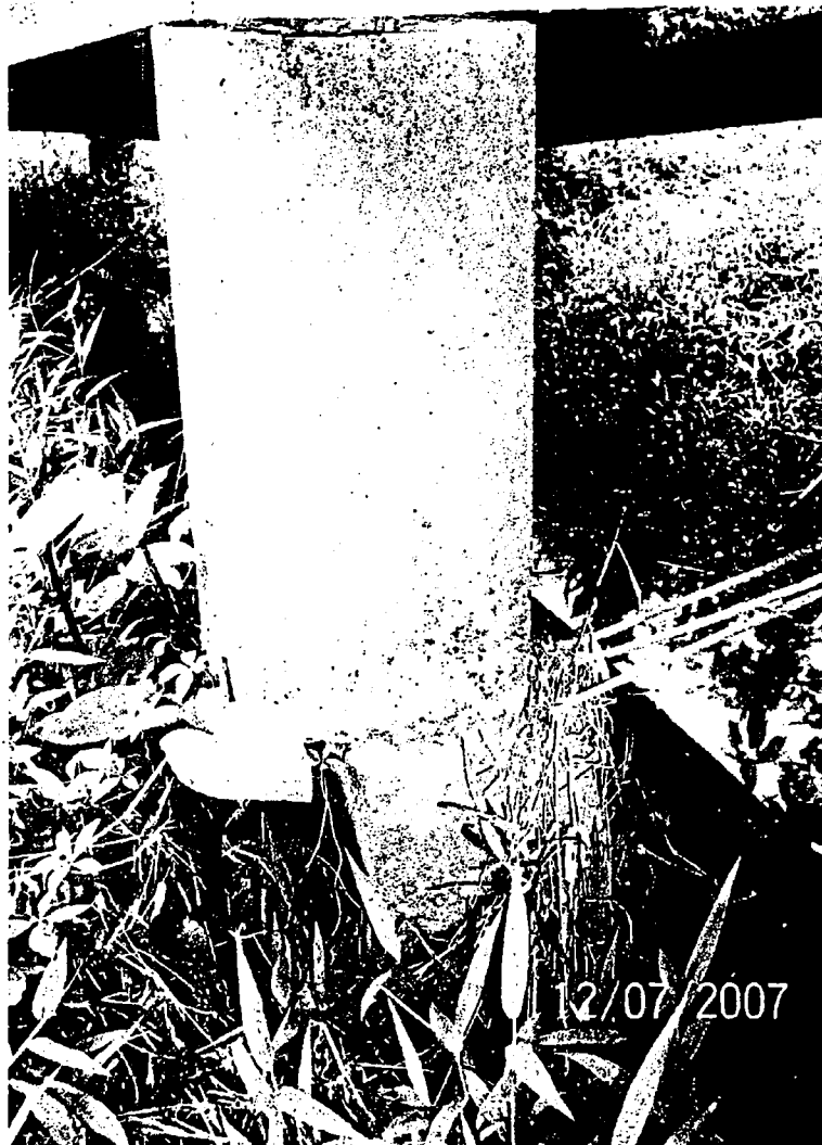
Foto 30 – Vista de outro pilar de concreto da passarela de madeira colapsada. Vê-se claramente a inexistência de uma fixação adequada entre o pilar e a superestrutura de madeira. Foto obtida em 12/07/2007.
