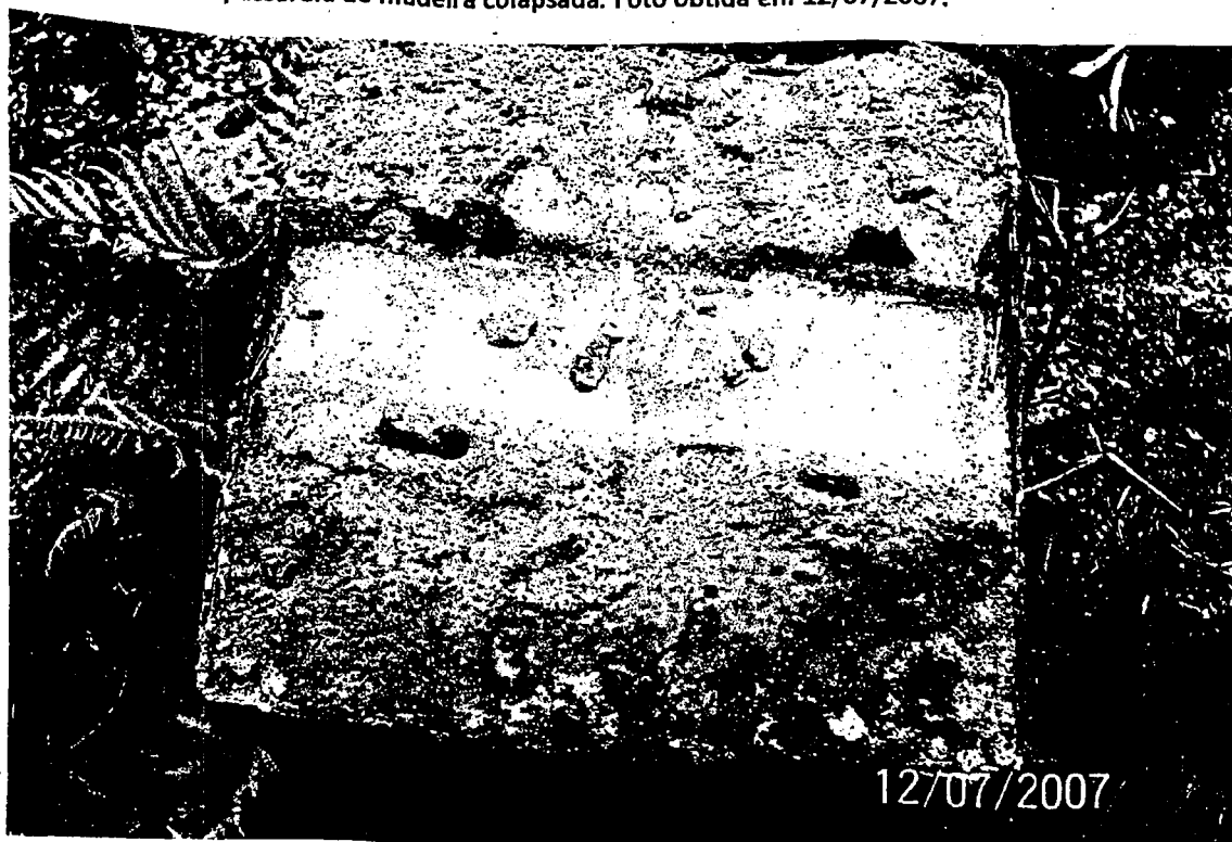
Foto 17 – Vista em detalhe do topo de um dos pilares que apoiavam a passarela colapsada. Foto obtida em 12/07/2007.
