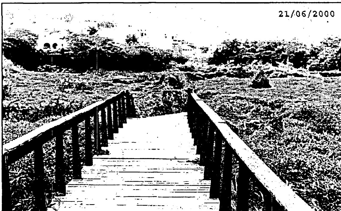
Foto 01 – Vista de uma das passarelas de madeira danificadas no Parque Cidade de Toronto. Foto obtida em 21/06/2000.
