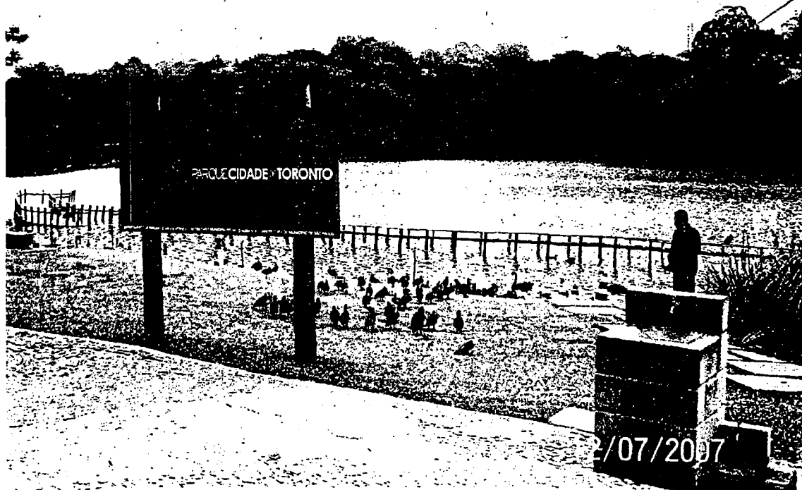
Foto 10 – Vista do deck de madeira arrancado dos seus pilares de apoio em uma chuva intensa ocorrida no início do ano. Foto obtida em 12/07/2007.
