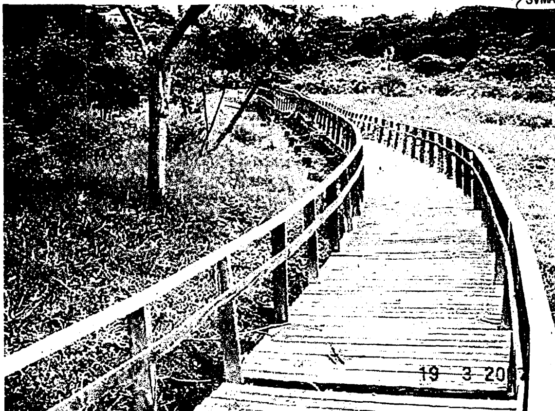
Foto 04 – Vê-se uma das passarelas de madeira do Parque Cidade de Toronto, que também foi removida de seus apoios (pilares de concreto) pela força da corrente de água decorrente de uma chuva intensa. Foto obtida em 19/03/2007.
