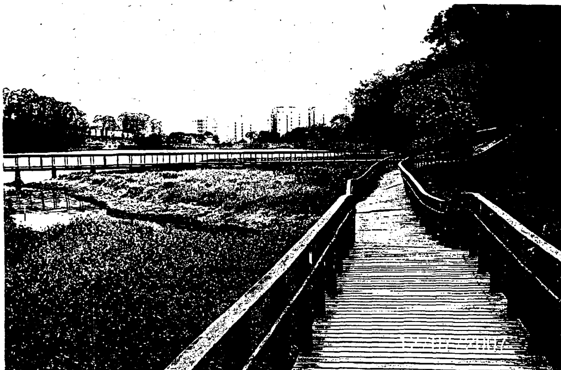
Foto 21 – Vista reversa da passarela de madeira colapsada. Ao fundo vê-se a outra passarela de madeira que não sofreu danos durante a chuva intensa ocorrida. Foto obtida em 12/07/2007.
