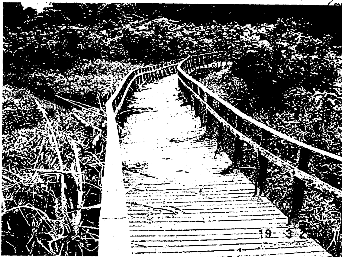
Foto 09 – Outro trecho da passarela de madeira colapsada, em decorrência da falta de amarração entre a super e a infraestrutura da mesma. Foto obtida em 19/03/2007.
