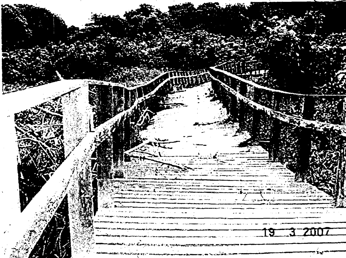
Foto 08 – Ainda outro trecho da passarela de madeira colapsada, em decorrência da falta de amarração entre a super e a infraestrutura da mesma. Foto obtida em 19/03/2007.
