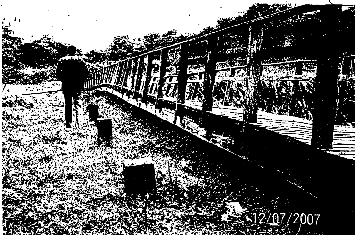
Foto 18 – Vista da passarela de madeira colapsada e de alguns dos seus pilares de apoio. Foto obtida em 12/07/2007.
