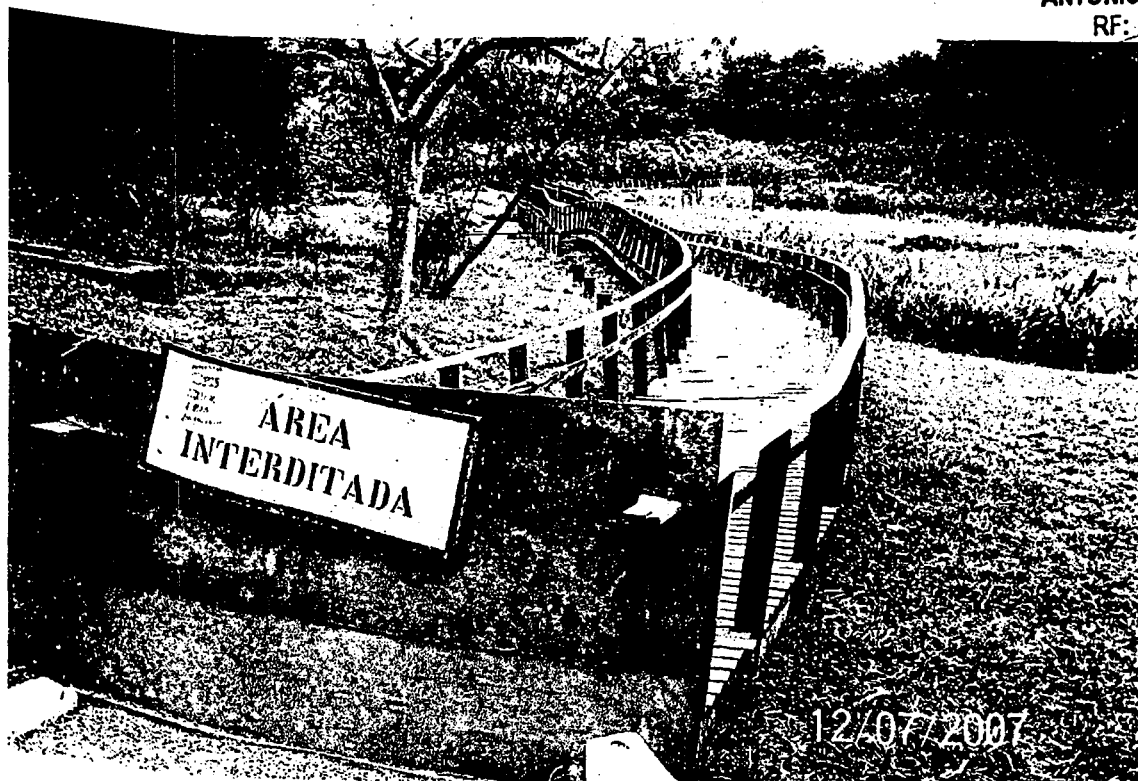
Foto 16 – Vista da passarela de madeira colapsada. Foto obtida em 12/07/2007.
