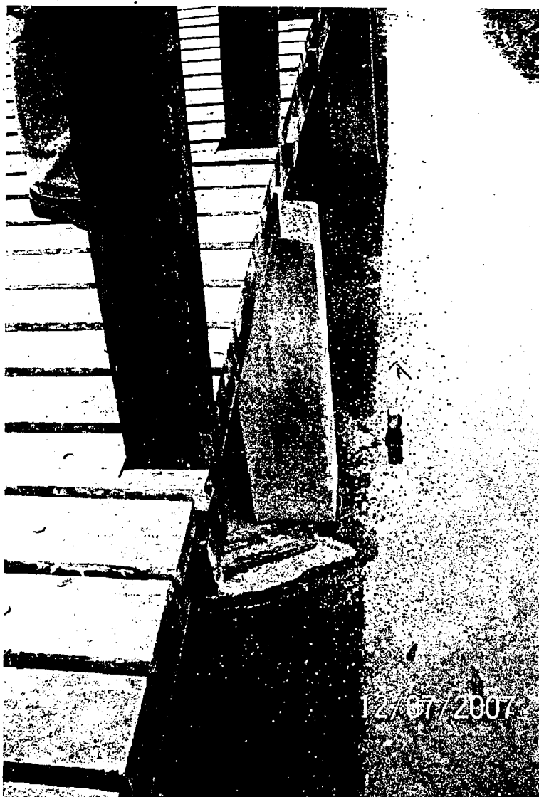
Foto 22 – Vista dos pilares e do bloco de fundação da passarela de madeira colapsada. Foto obtida em 12/07/2007.
