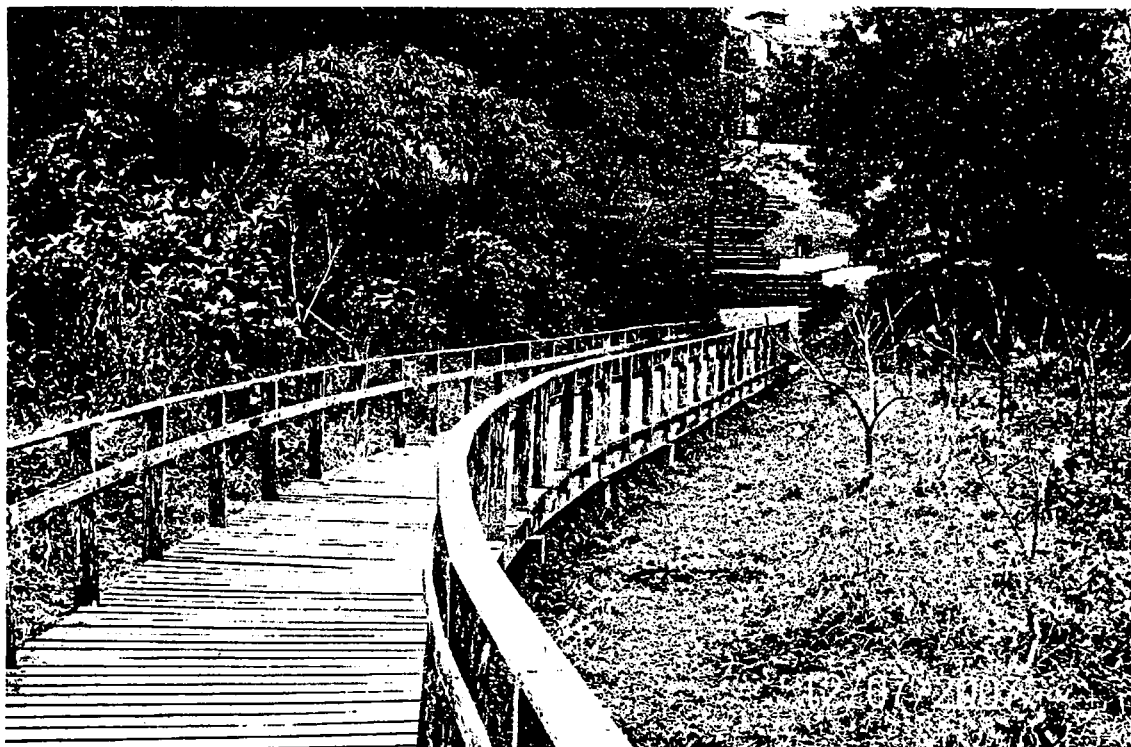
Foto 26 – Vista do trecho final da passarela de madeira colapsada, que se manteve íntegro. Foto obtida em 12/07/2007.
