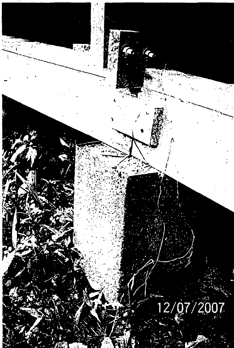
Foto 28 – Vista de um ponto de apoio intacto da passarela de madeira colapsada. Este ponto situa-se no trecho final da passarela, onde a força da água foi mínima, preservando a estrutura. A superestrutura de madeira foi simplesmente apoiada no pilar, sem qualquer amarração ou travamento lateral. Foto obtida em 12/07/2007.
