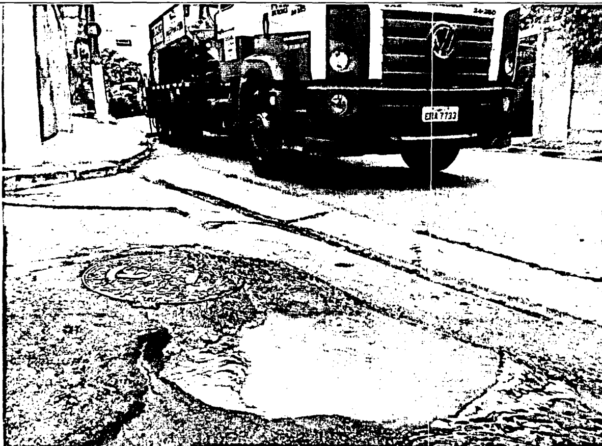
Vazamento de Esgoto na confluência da Rua Darcy Lima da Glória com a Rua dos Mendes.
