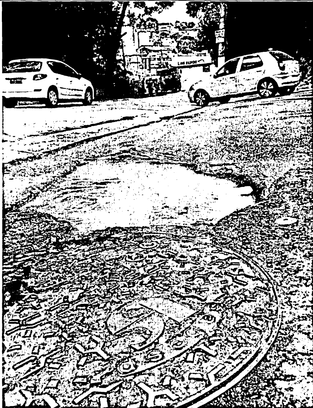
Vazamento de Esgoto na confluência da Rua Darcy Lima da Glória com a Rua dos Mendes.
