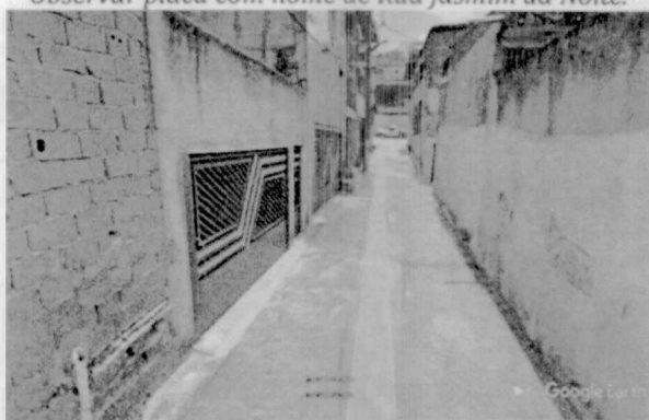
Rua Particular 1 da planta AU 6452. Segundo trecho, após curva, à direita da anterior. Google™ earth Street View 02/2015.
