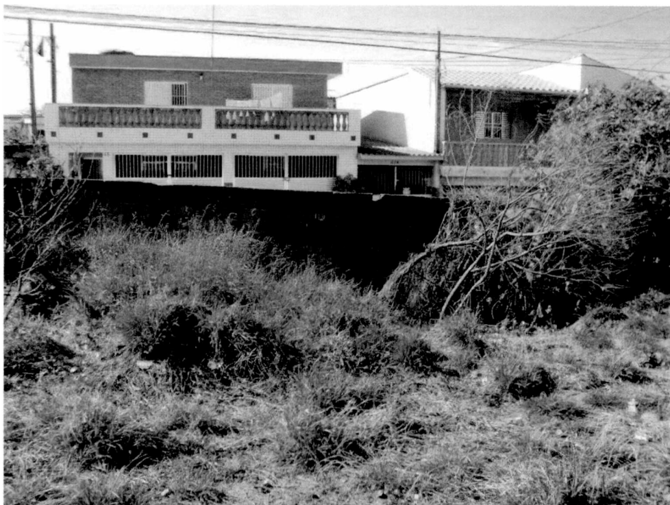
Foto 5 – Vista interna do muro de fechamento.
