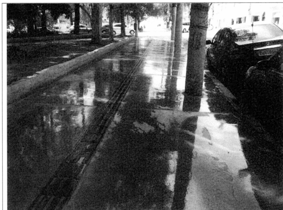
Imagem nº 33: Calçada com acabamento superficial bambolê após a reforma.
