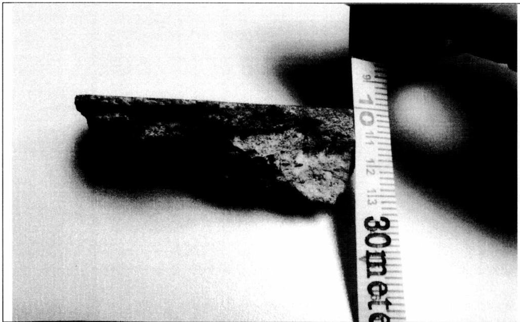
Imagem nº 26: Calçada executada com espessura inferior a 4 cm.
