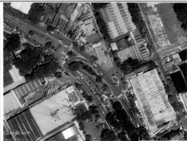
Imagem 13: Trecho próximo à ponte do Socorro, com muitos retornos e encurtamento do canteiro.
