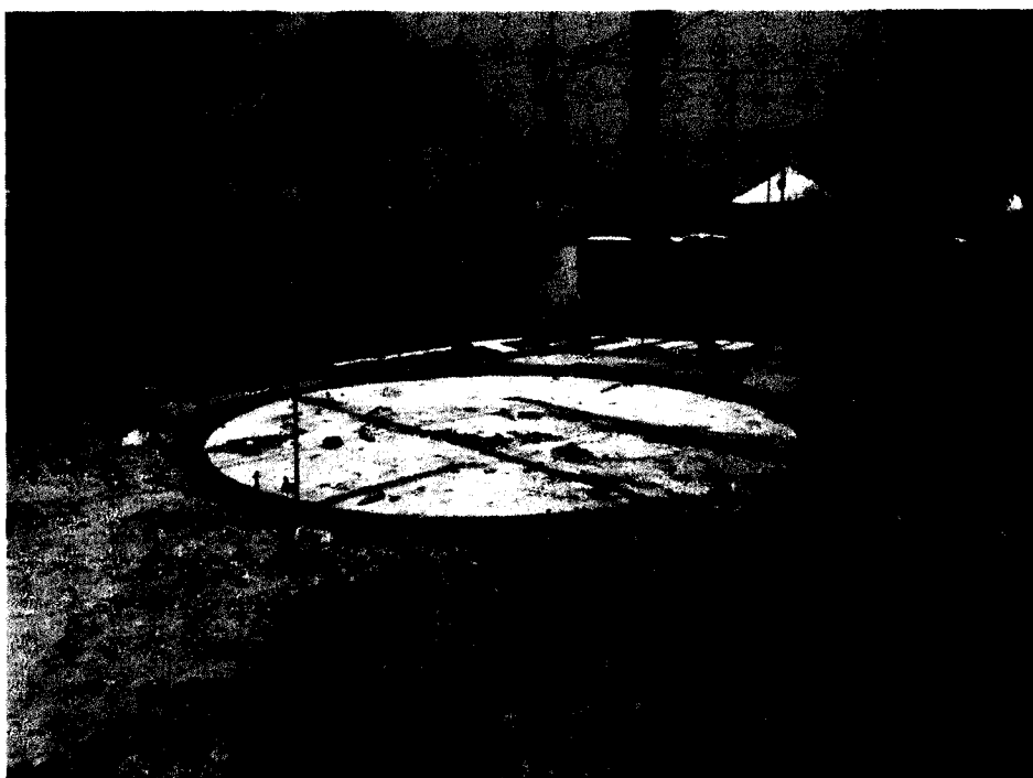
Imagem 17 – Frente 13 – CT Cordeiro – Fechamento provisório – PV 6
