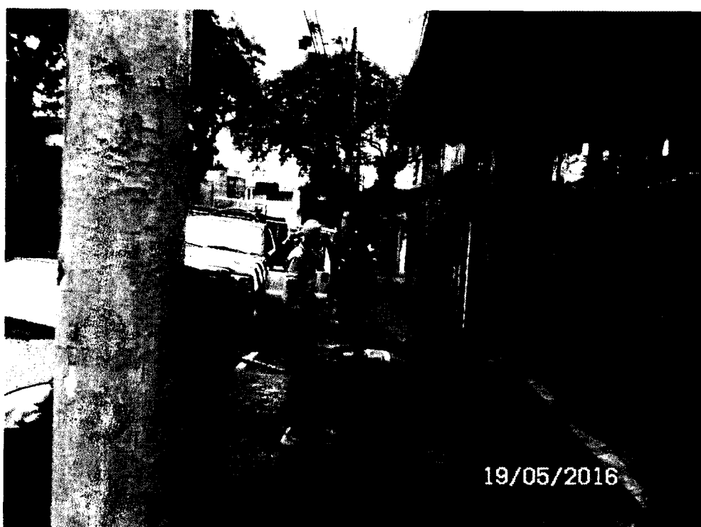
Imagem 14 – Reparo de rede
