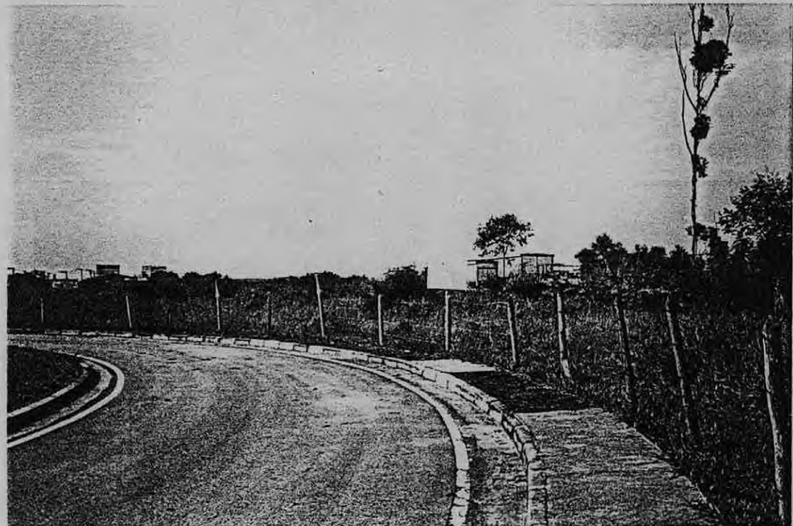
Foto n.º9 - Rotatória Junto a r. João Lopes Maciel e ETE-São Miguel SABESP
