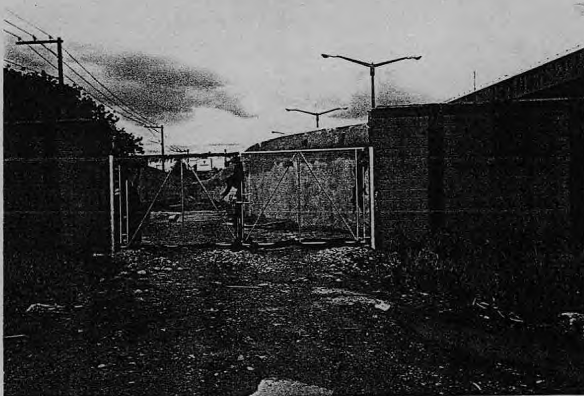
Foto nº2 - Muro existente na Av. Dr. José Artur Nova e o executado pela Votorantins metais
