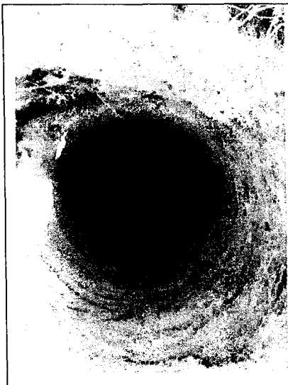
Imagem 05. Furo escavado para realização de estaca de concreto armado. Foto da época da obra.
