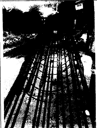
Imagem 07. Armadura de estaca. Foto da época da obra.
