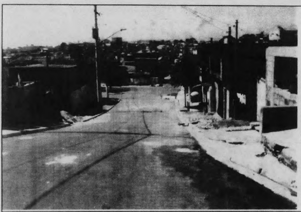
FOTO 2 VISTA DA RUA ESPUMAS Local com infra-estrutura, drenagem superficial e sem ligações domiciliares de esgoto
