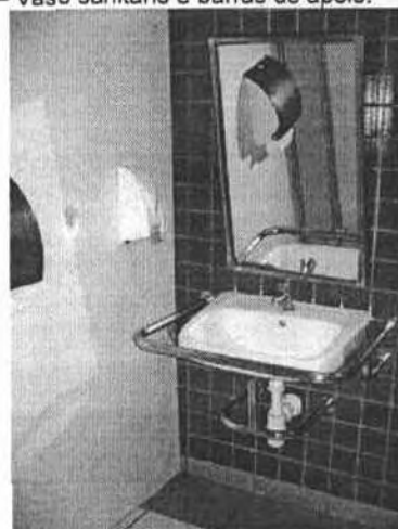
Fig. 18 – Lavatório interno do boxe acessível.
