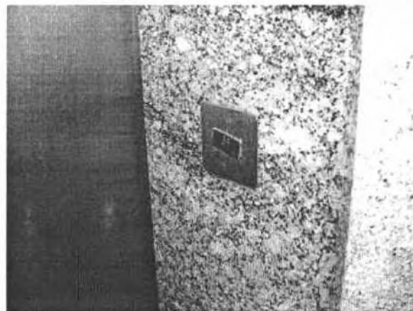
Fig. 68 – Sinalização em Braille no batente.
