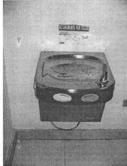
Fig. 79 – Permite aproximação frontal de PCR.
