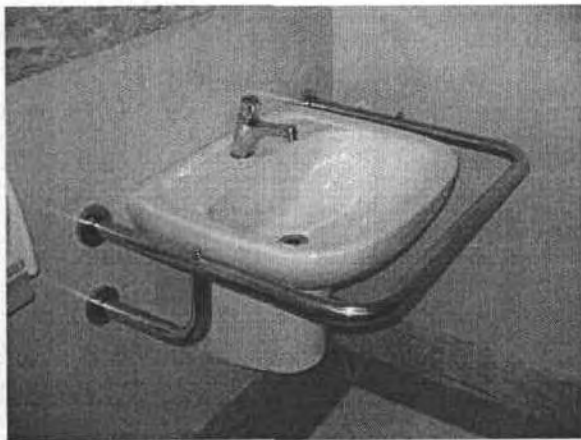
Fig. 42 - Lavatório sanitário adaptado unissex - Térreo
