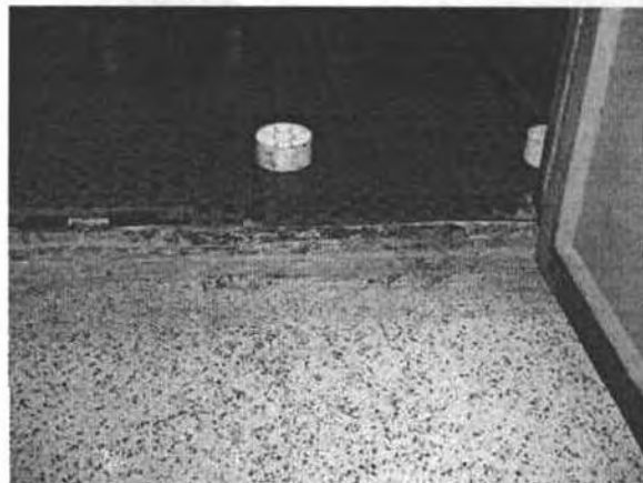
Fig. 3 – Desnível na soleira no acesso de PCR ao cinema.
