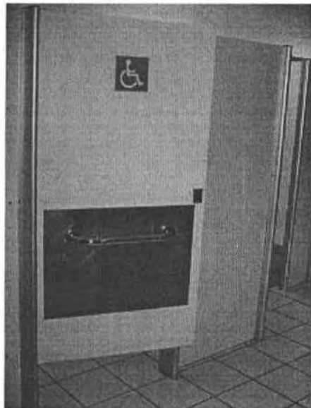
Fig. 19 – Sinalização SAI – Boxe Acessível
