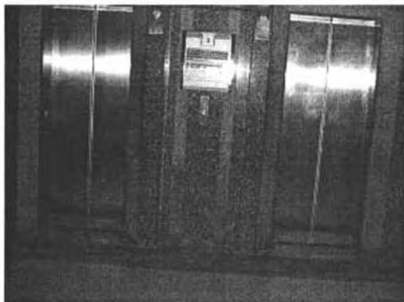
Fig. 67 – Elevadores sociais (Piso 3)
