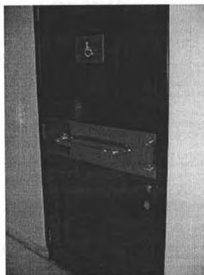
Fig. 53 – Puxador horizontal externo
