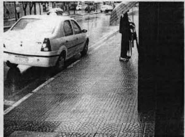
Fig. 26 – Passeio em bom estado de conservação.
