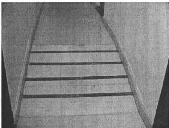
Fig. 33 – Rampa de acesso ao Sanit, Masculino Térreo.
