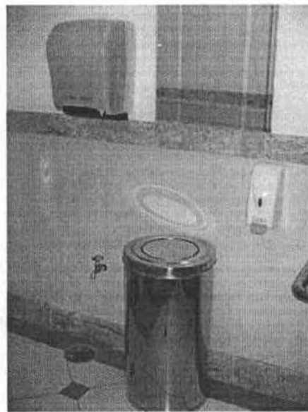
Fig. 41 – Acessórios fora da faixa de alcance.
