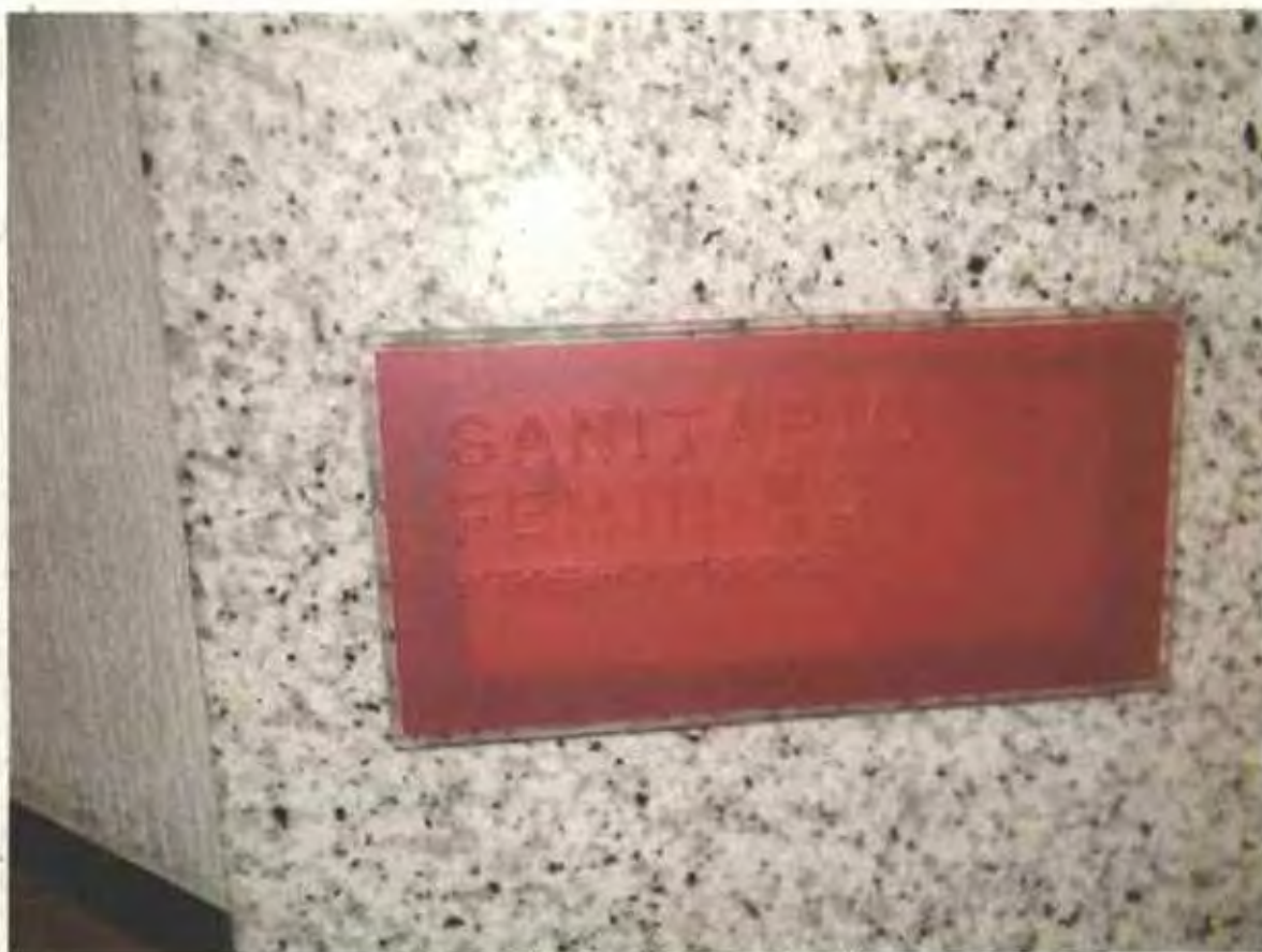
Figura 16 - Placa em Relevo e Braille
