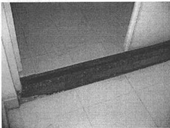
Fig. 44 – Soleira com tratamento em rampa.
