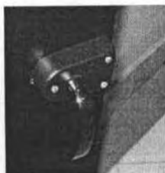
Fig. 54 – Detalhe da fechadura adaptada de fácil manuseio.
