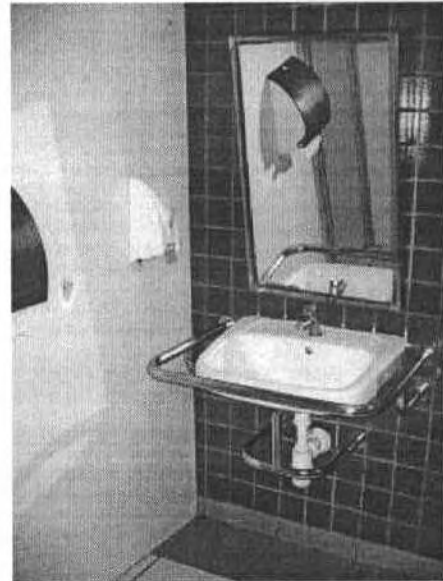
Fig. 35 – Lavatório (Boxe Adaptado)
