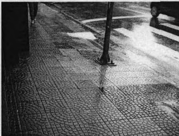
Fig. 25 – Passeio sem demarcação das diferentes faixas.
