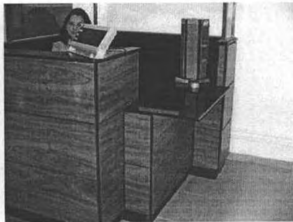
Fig. 56 – Balcão do caixa com duas alturas.
