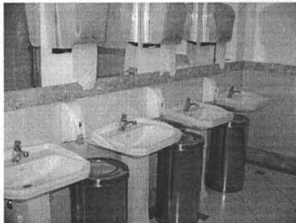
Fig. 39 – Sanitário Feminino (reformado – Térreo)
