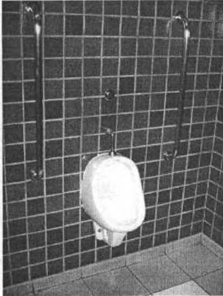
Fig. 34 – Mictório – Sanitário Pavimento Térreo (Integrado)
