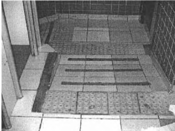
Fig. 31 – Rampas internas no sanitário do Pav. Térreo
