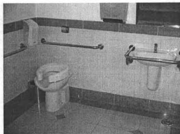
Fig. 50 – Vaso adaptado acrescido de assento. (inadequado)
