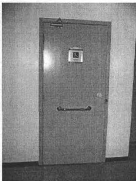
Fig. 4 – Porta Sanitário Adaptado (Cinema)
