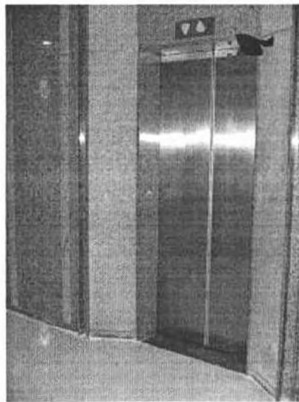
Fig. 70 – Elevador panorâmico social (Piso 1)
