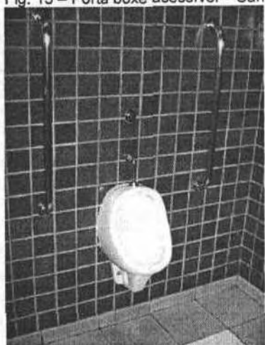
Fig. 17 – Mictório adaptado.
