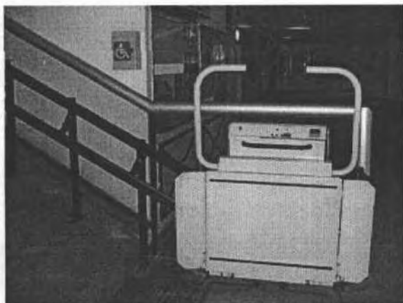
Fig. 1- Plataforma inclinada para acesso aos cinemas.
