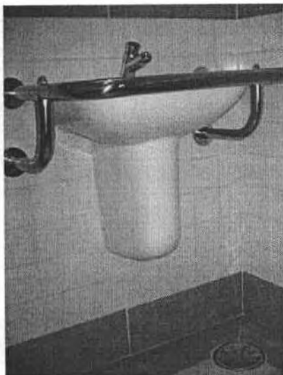
Fig. 52 – Lavatório com barra de apoio.
