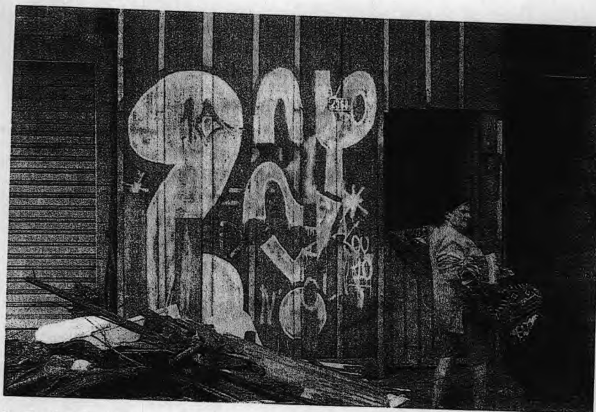
Fotografia 2: Fachada do conjunto de residências. À direita, o corredor de acesso ao imóvel onde houve o sinistro.
